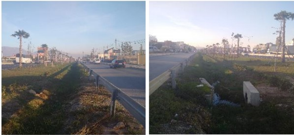
Figure 23 – Shembull i kanalit te hapur ekzistues pergjate aksit te TR-DR
