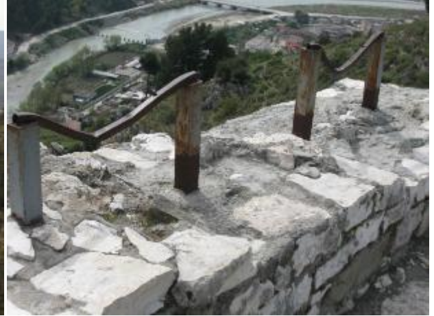
Figura 1-2- Demtimi ne pjesen e sipërme te murit dhe parmaku
