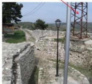
Bazamenti beton i antenes ka demtuar muret perimetral te kulles
