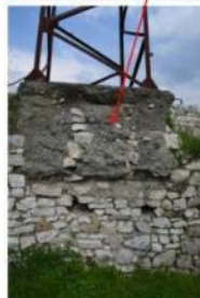
Bazamenti beton i antenes ka demtuar muret perimetral te kulles
