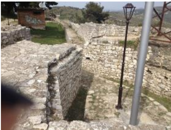
Figura 1-1 Demtimi ne pjesen e sipërme te murit
