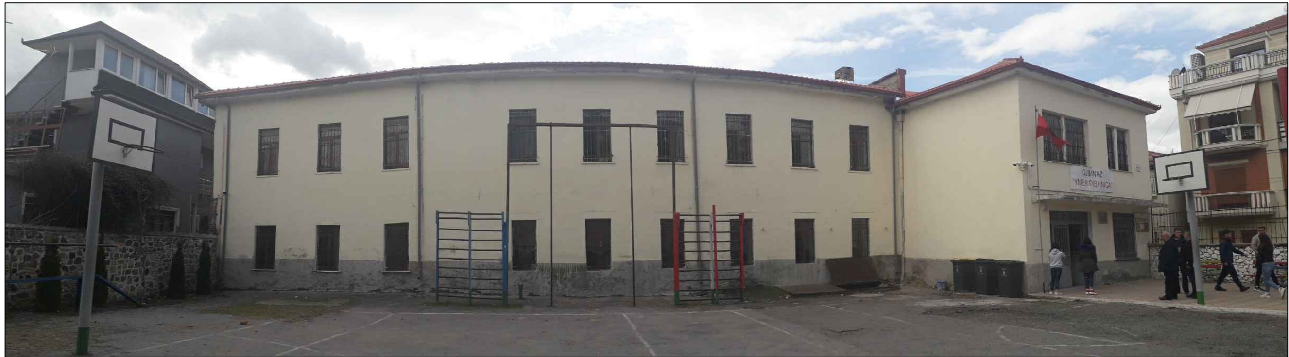
Foto fasada Veriore , hyrja kryesore e shkolles
