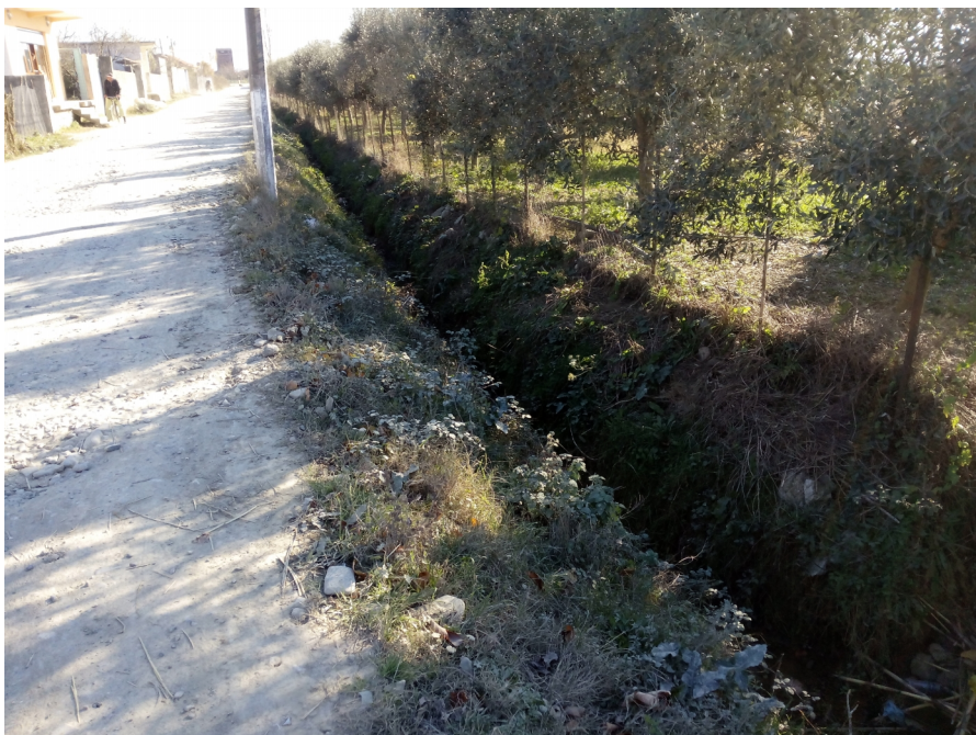
2. Kanali kullues në anën e poshtme të rrugës
