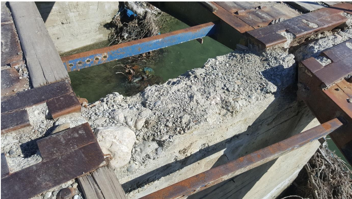
Foto te Gjendjes Ekzistuese
