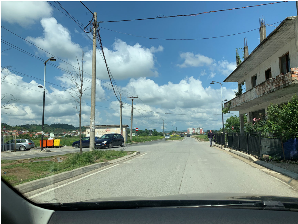
Foto 5. Gjendja ekzistuese e rruges “Bulevardi Kashar “
