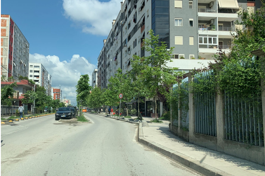
Foto 1. Gjendja ekzistuese e rruges "Tom Plezha dhe Bulevardi Kashar"
