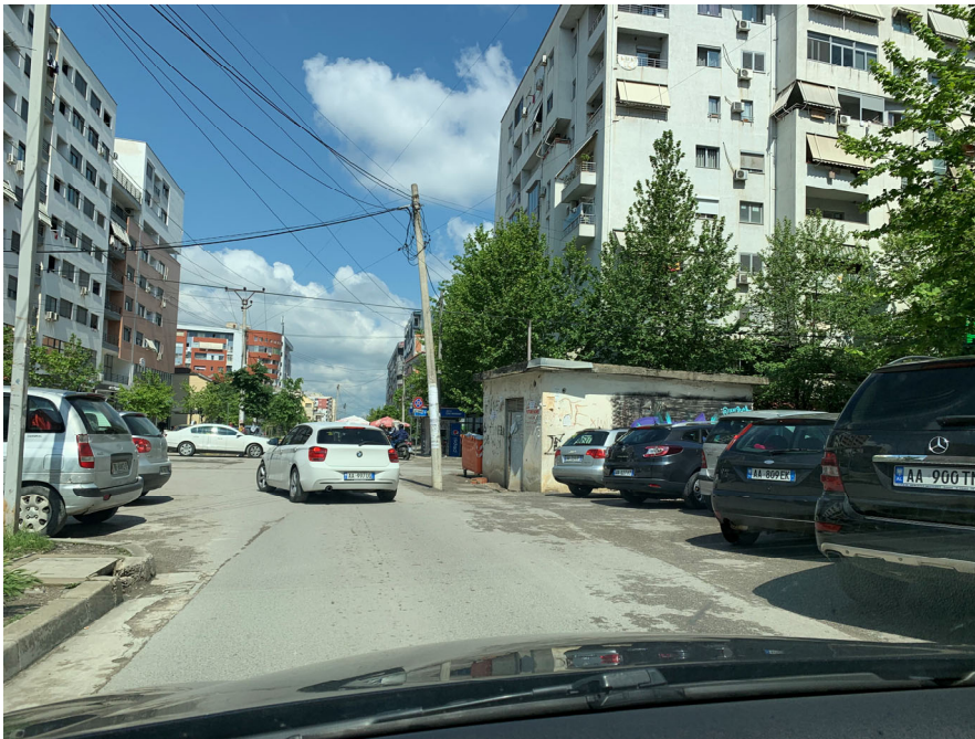
Foto 4. Gjendja ekzistuese e rruges “Bulevardi Kashar “
