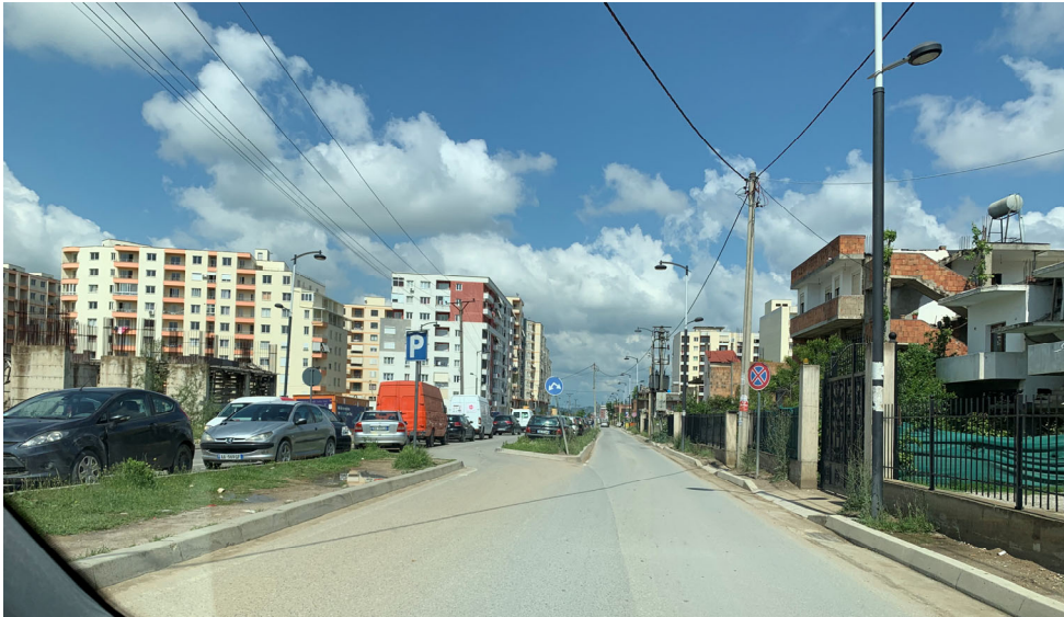
Foto 5. Gjendja ekzistuese e rruges “Bulevardi Kashar “
