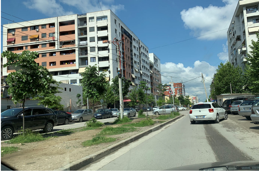
Foto 3. Gjendja ekzistuese e rruges “Bulevardi Kashar “
