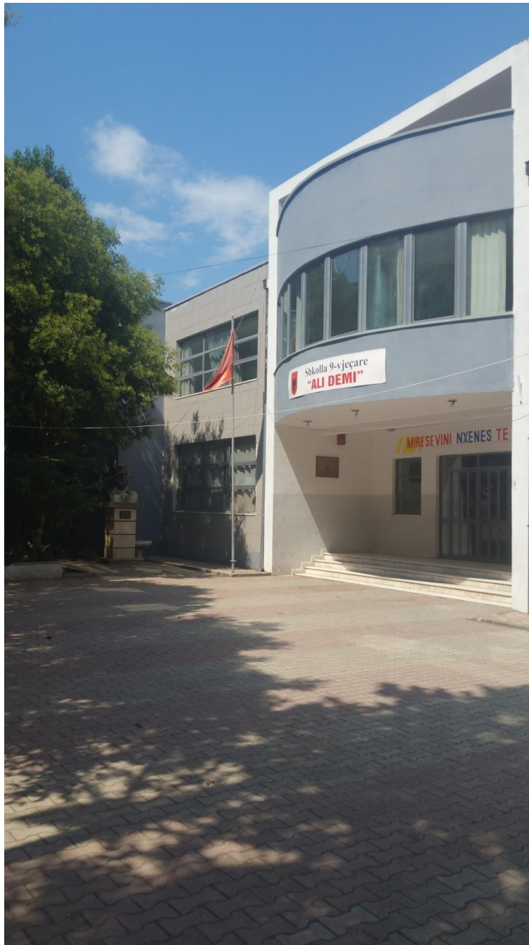
Figura 1. Foto e gjëndjes ekzistuese.
