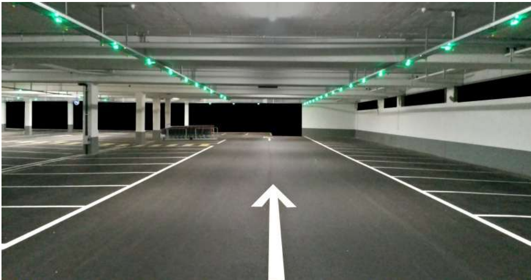
Shembull i përdorimit të sensorve ultrasonik të kombinuar me sinjalizues në parkim
