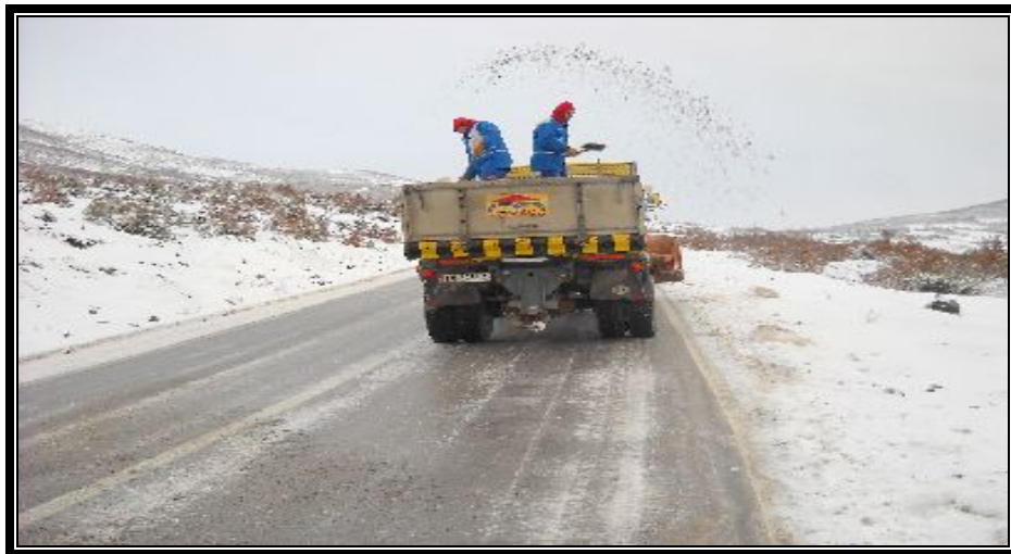
Fig. Ilustruese: Shpërndarja e kripes në mënyrë manuale
