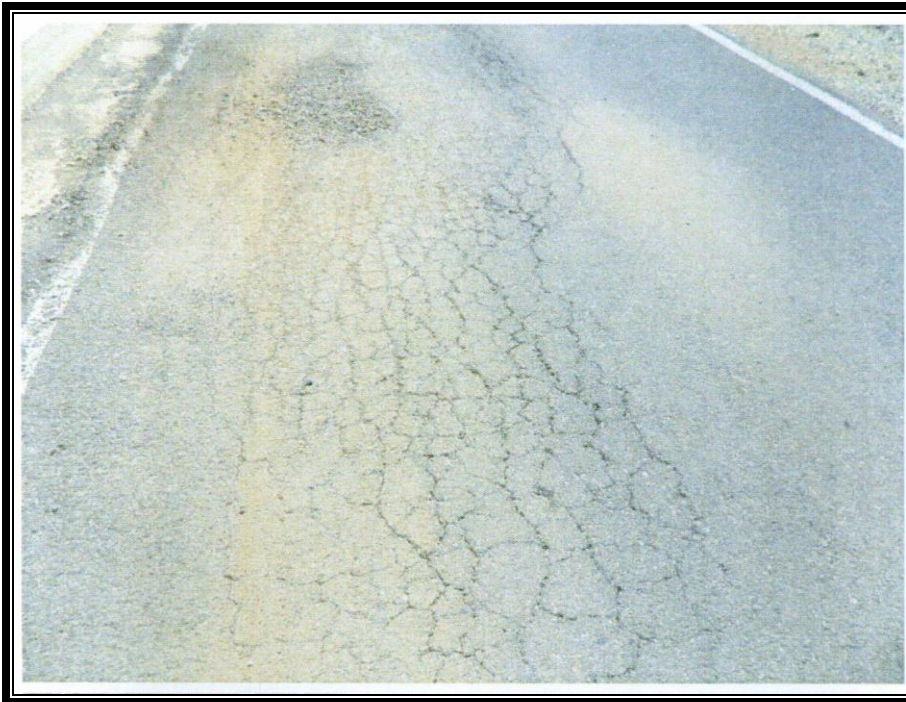
Shembull të plasaritjeve në forme rrjetë por dhe cedim të shtresave
