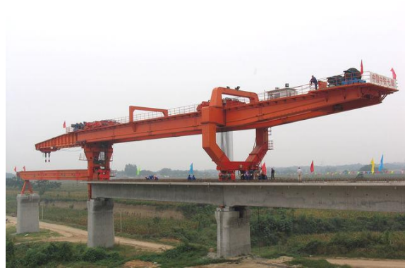
Figura 6-1 Vendosja e trarëve në vepër për lartësi pile <20.00mdhe me te madhe se 20m
