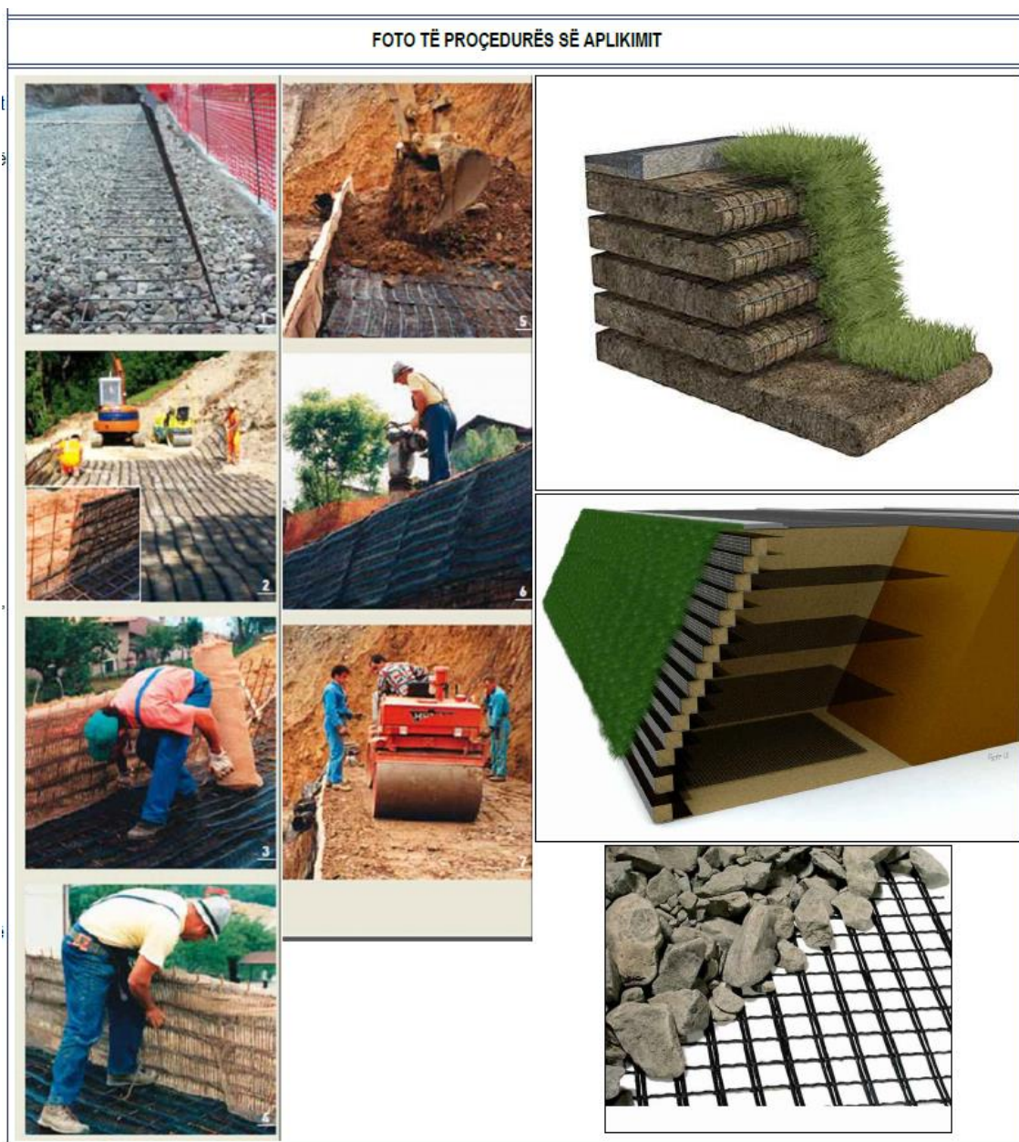
Figura 10-2 Foto të procedurës së aplikimit të Geogridit të përdorur
