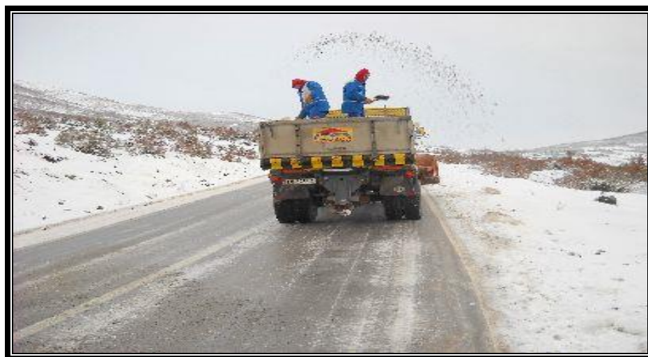
Fig. Ilustruese: Shpërndarja e kripes në mënyrë manuale
