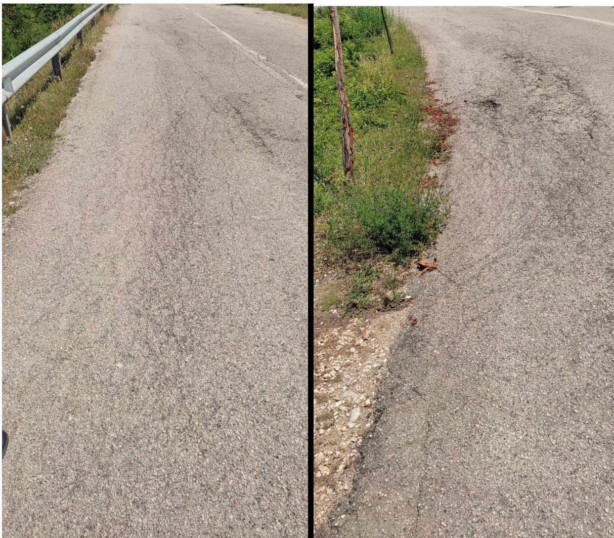
Figura 3-3: Pamje të cedimeve të rrugës dhe plasaritjeve të asfaltit ne anën e majte.
