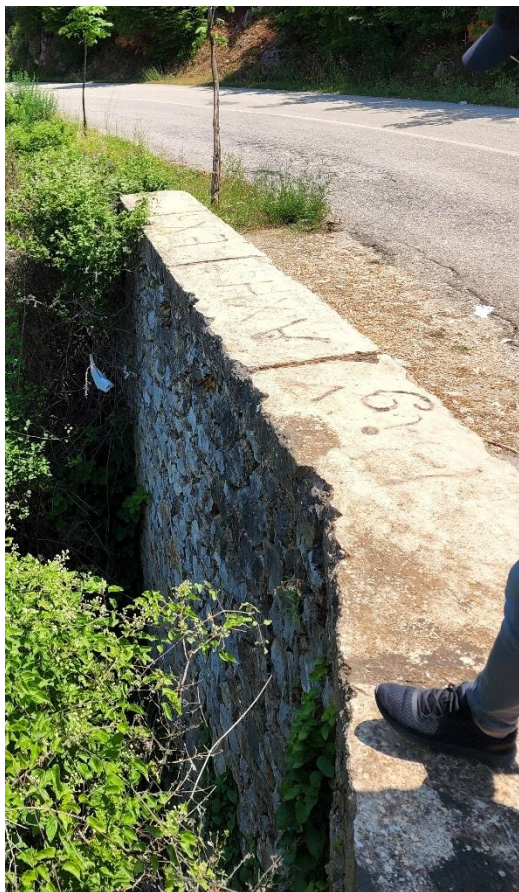
Figura 3-7: Mure ekzistues prej guri
