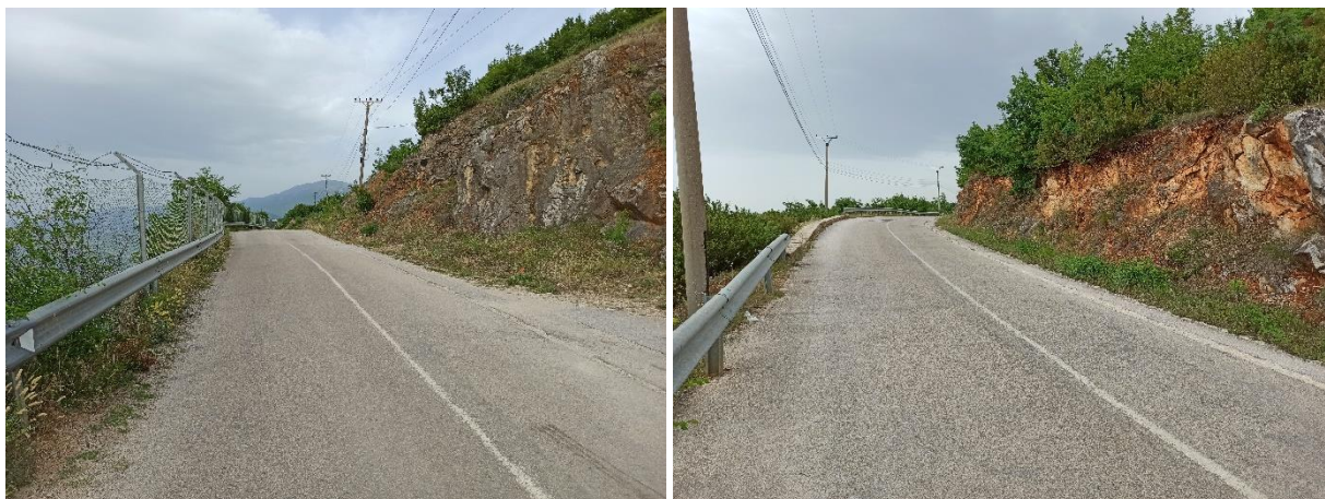
Figura 3-5: Infrastruktura elektrike përgjatë rrugës
