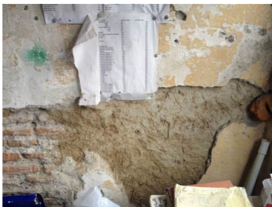
Fig. 10. Majtas lart: Muraturë me tullë me suva të përforcuar me kashtë (objekti ekzistues). Djathtas lart: Përforcimi i muraturës me çimento të përforcuar me fibra xhami. Majtas poshtë: Paraqitja e fibrave të xhamit.
