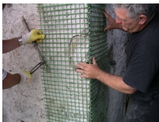
Fig. 10. Majtas lart: Muraturë me tullë me suva të përforcuar me kashtë (objekti ekzistues). Djathtas lart: Përforcimi i muraturës me çimento të përforcuar me fibra xhami. Majtas poshtë: Paraqitja e fibrave të xhamit.
