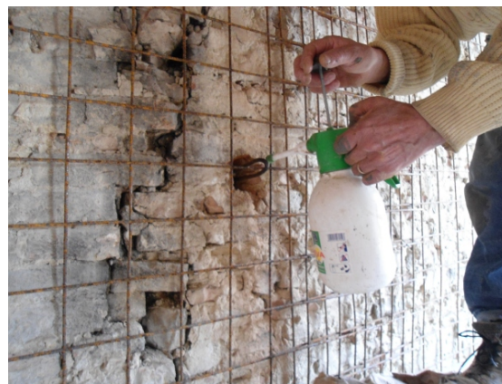
Fig.11. Majtas: Mënyra e vendosjes së çimentos së përforcuar me rrjetë çeliku të elektro-salduar. Djathtas: Shembull i aplikimit të përforcimit me rrjetë çeliku.
