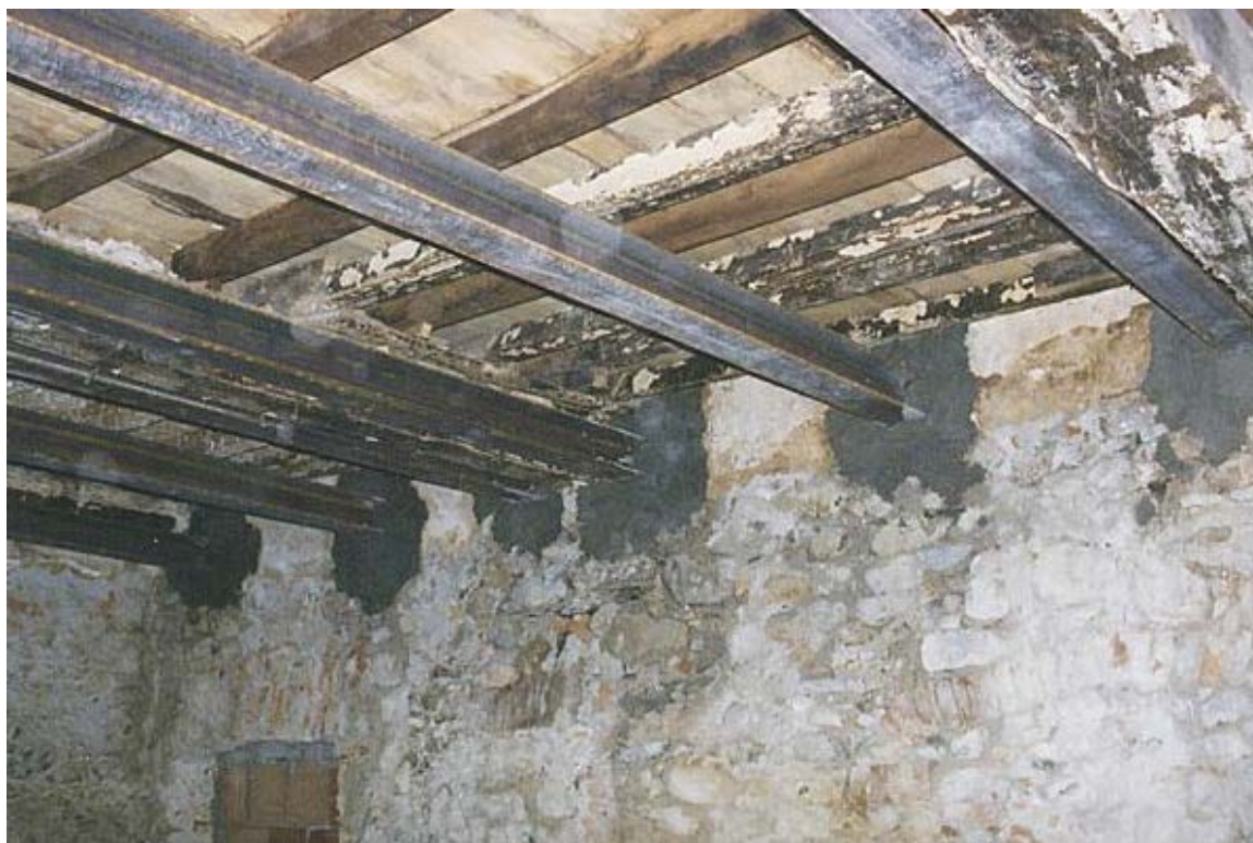
Fig.9. Trarët dopio T për të rritur aftësinë mbajtëse dhe rigjeditetin e diafragmave.
