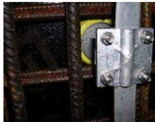
Figura 48 : Detaj i fiksimit të shiritit të tokëzimit në zgaren e hekurit për nxjerrjen e terminalit të fiksuar të tokezimit
