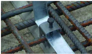
Figura 47 : Detaj i fiksimit të shiritit të tokëzimit në zgaren e hekurit
