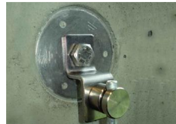
Figura 48 : Detaj i fiksimit të shiritit të tokëzimit në zgaren e hekurit për nxjerrjen e terminalit të fiksuar të tokezimit
