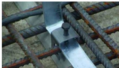
Figura 47 : Detaje konstruktive te sistemi te tokezimit
