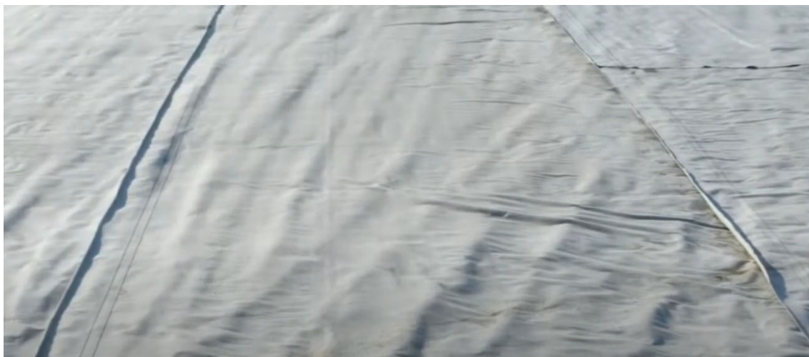
Figura 57: Pamje perfundimtare e ngjitjes membranës me argjilë gjeosintetike (GCL)
