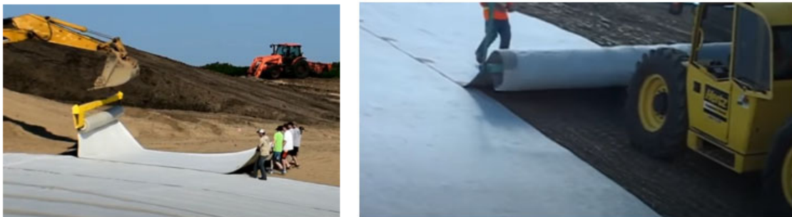
Figura 51: Shtrimi i membranës me argjile gjeosintetike (GCL)
