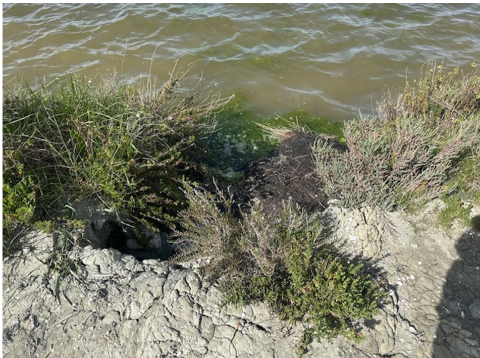
Figura 27: Pamje e argjinatures ne anen veriore te Lagunes prishur nga erozioni shkaktuar nga veprimi I dallges.
