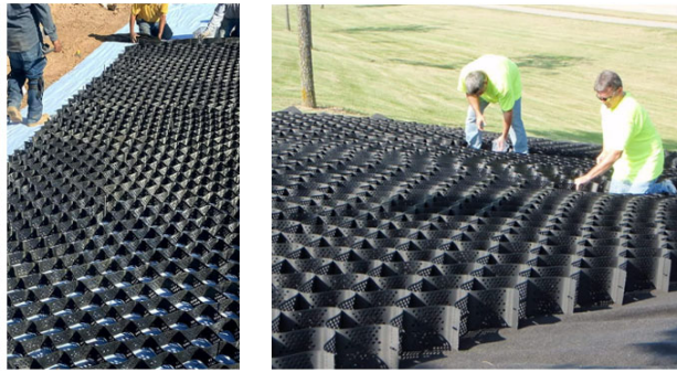
Figura 64: Pamje e vendosjes e Geocell ne sipërfaqen që kërkohe.
