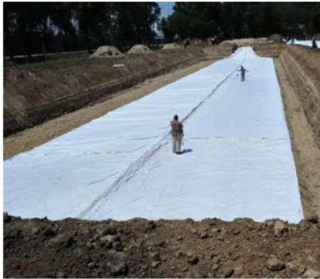
Figura 54: Mbivendosjet e membranës me argjilë gjeosintetike (GCL)
