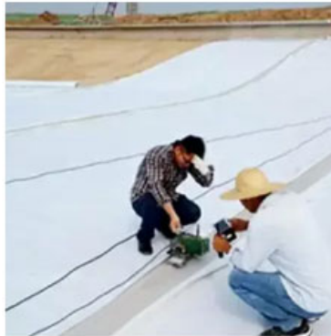
Figura 55: Pamje nga ngjitja e membranës me argjilë gjeosintetike (GCL)
