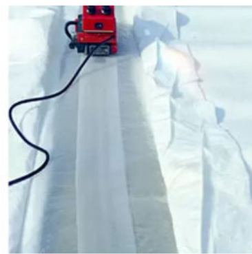
Figura 55: Pamje nga ngjitja e membranës me argjilë gjeosintetike (GCL)
