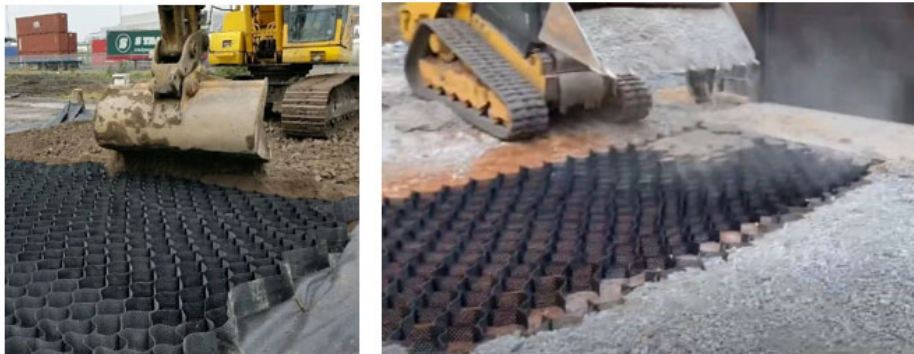
Figura 65: Aplikimi i shtresave ne Geocell
