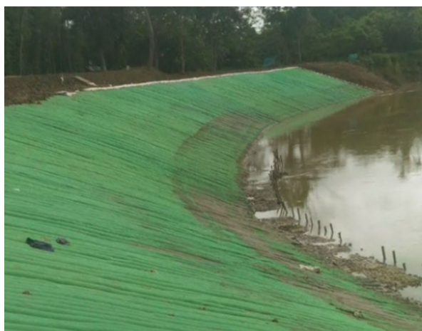
Figura 37: Pamje e argjinaturës me mbrojtje me dysheke gjeotekstili të mbushur me rërë
