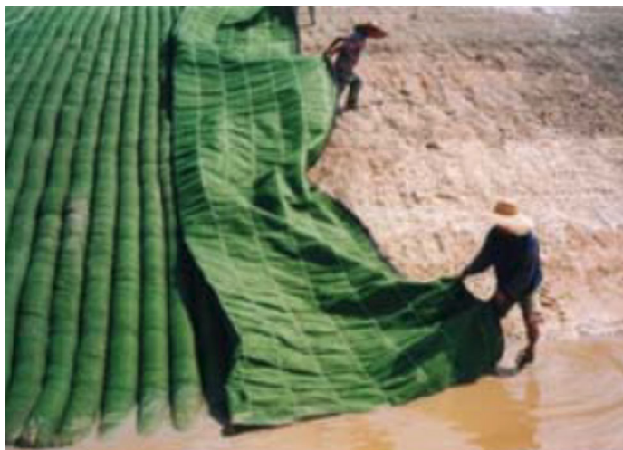
Figura 40: Instalimi i dyshekëve të gjeotekstil të mbushur me rërë ( sand filled mattress ).
