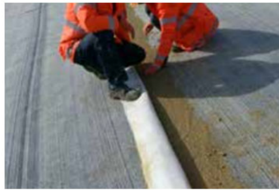
Figura 54: Mbivendosjet e membranës me argjilë gjeosintetike (GCL)
