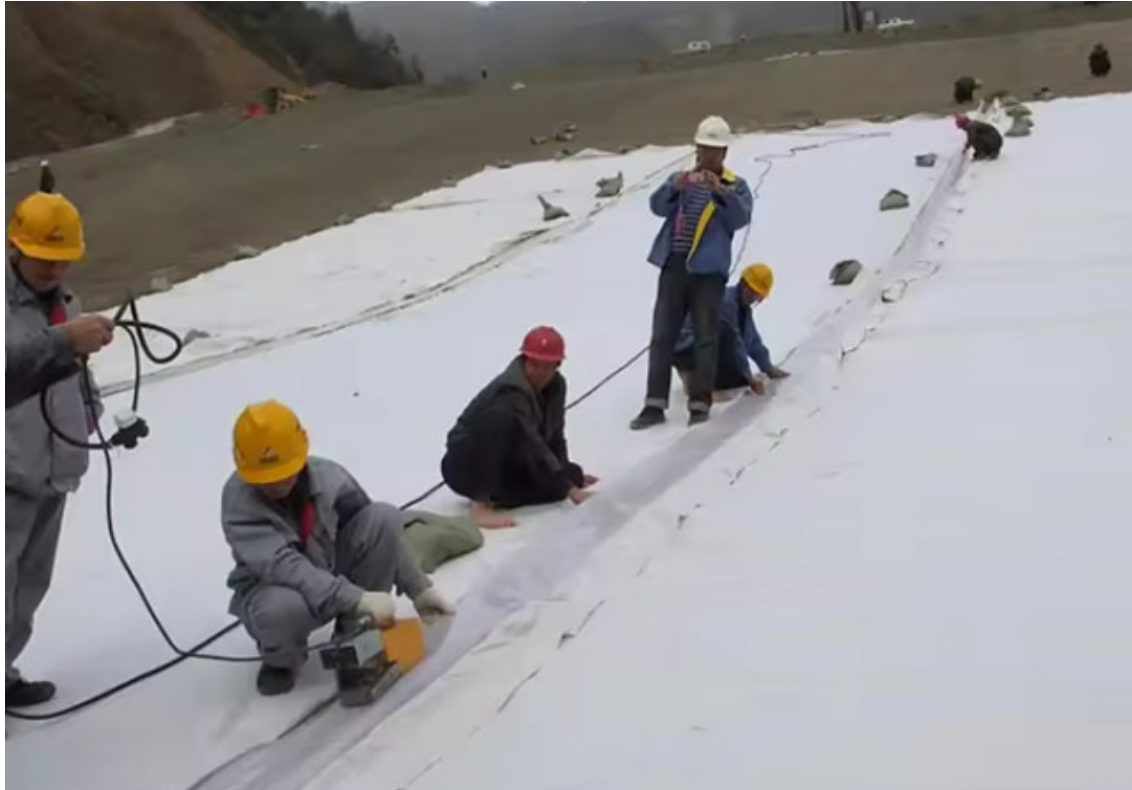
Figura 56: Pamje nga ngjitja e membranës me argjilë gjeosintetike (GCL)
