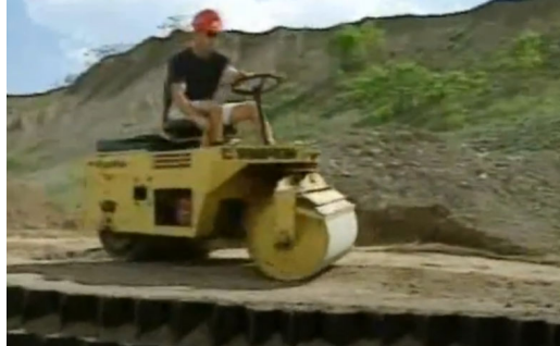
Figura 66: Ngjeshja e shtresave ne Geocell
