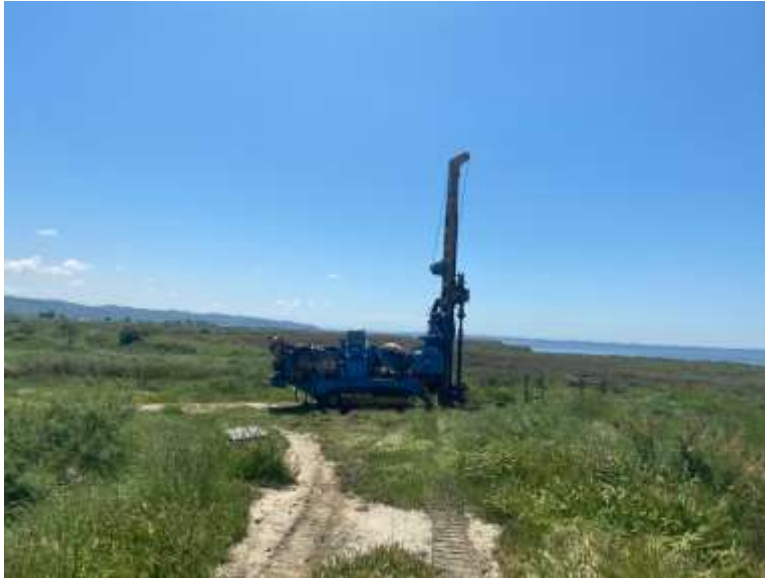
Foto nr.1 Pozicioni i sondes ne BH-K.1
