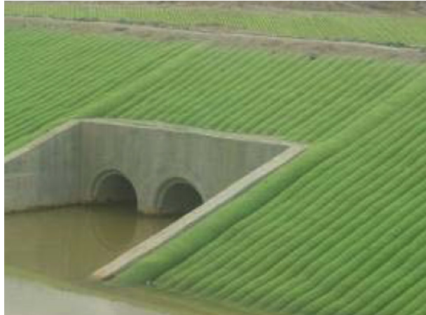
Figura 38: Pamje e argjinaturës me mbajtje me dyshekë gjeotekstili të mbushur me rëre në një vepër arti.
