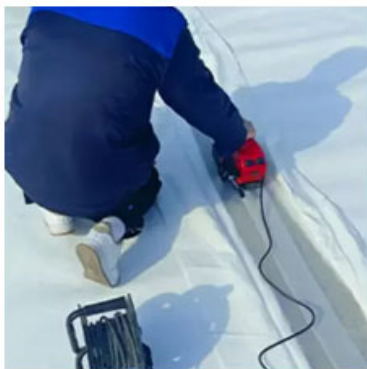
Figura 55: Pamje nga ngjitja e membranës me argjilë gjeosintetike (GCL)
