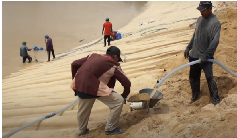
Figura 42: Procesi i mbushjes me rërë dhe uje i tubit nepermjet nje hinke
