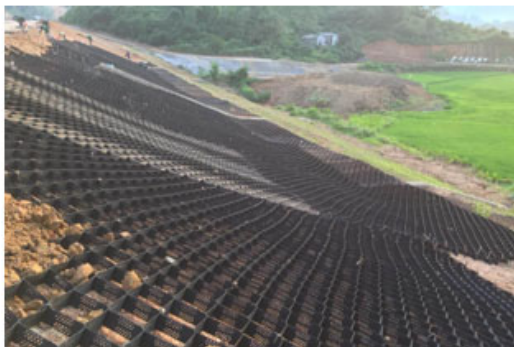
Figura 63: Aplikimi i Geocell në projektet e mbrojtjes së shpateve
