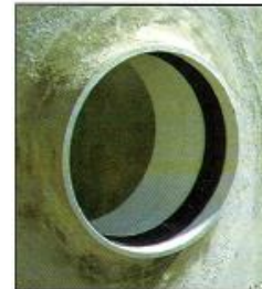
Izolimi i manikotës dhe i mbushjes me material hidroizolues
