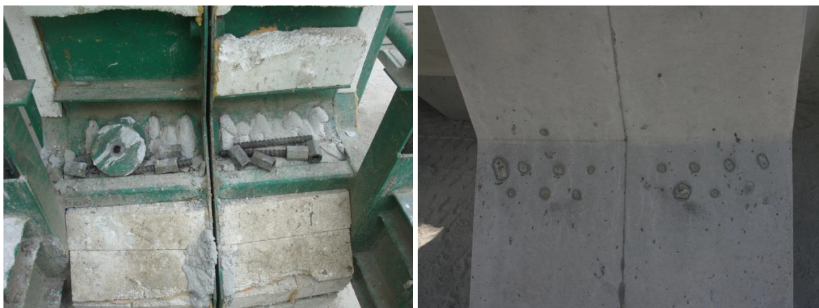
Figura 5-6: Vrimat e shpuara në kallëp për të parandaluar/zvogëluar çarjet në këndet e brendshme
