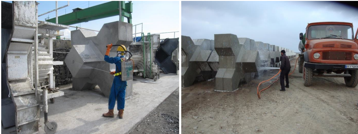
Figura 5-5: Kurimi i betonit të ekspozuar pas goditjes së kallëpit
