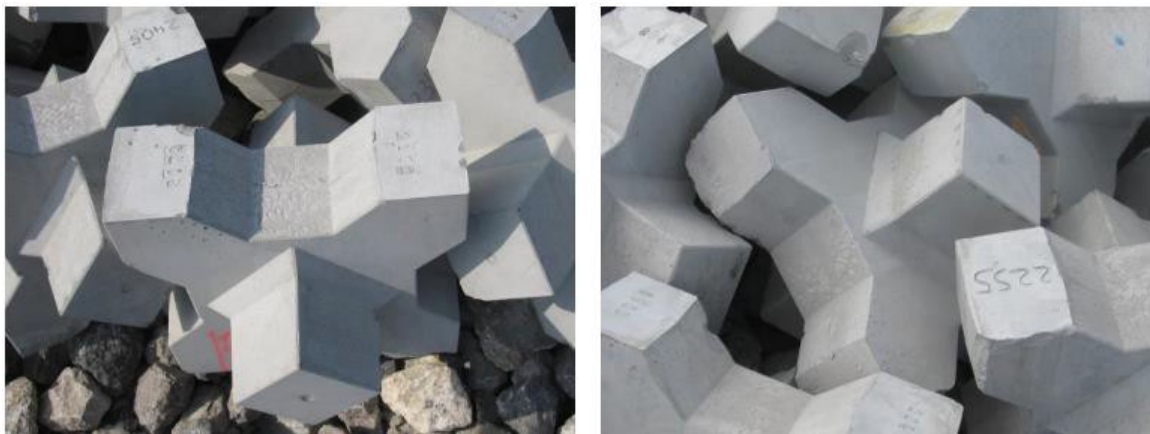
Figura 8-3: Orientimi i njësisë i vendosur në kreshtë: në 2 këmbë ose në 3 pikë
