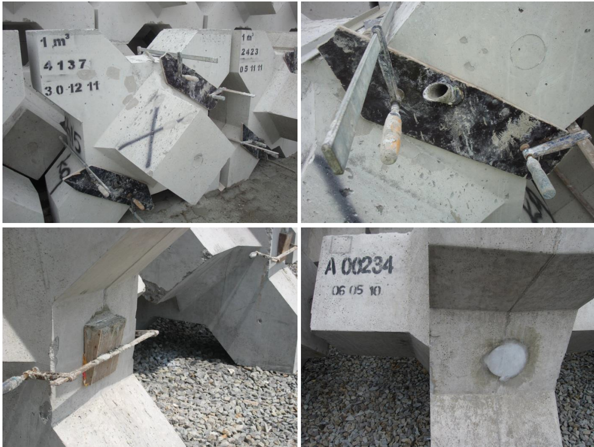
Figura 4-7: Riparimi i vrimave të shpimit me rezervuarë për tepricën e Ilaçit
