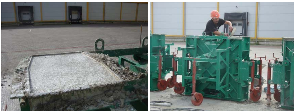
Figura 5-1: Majtas, vendosja e betonit dhe e djathta, rimbushja e kallëpit
