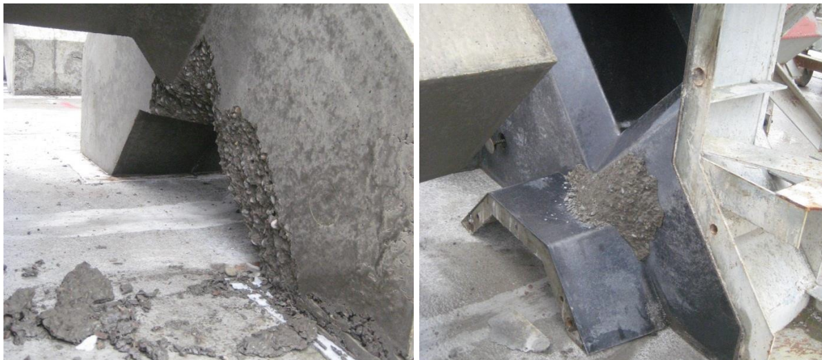
Figura 4-4: Dëmtime mekanike në sipërfaqe pas goditjes së kallëpit
