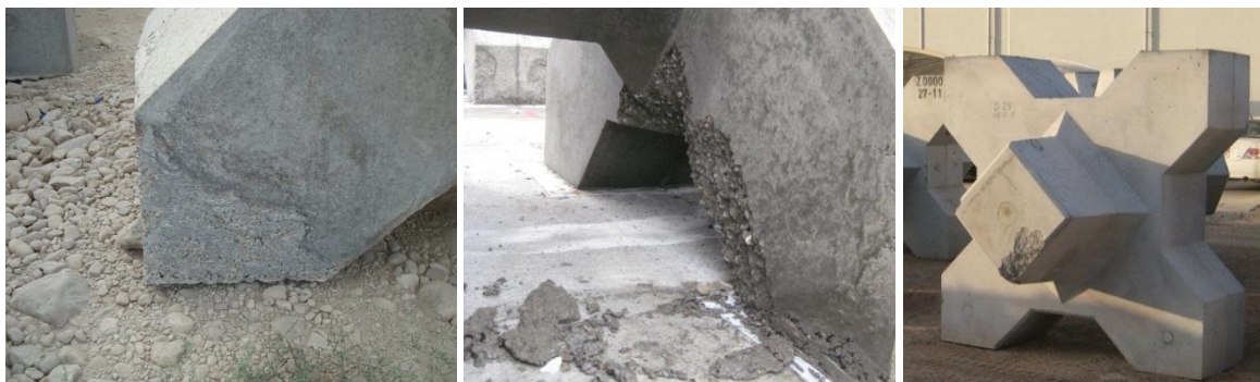
Figura 3-5: Shembuj të gërvishtjes dhe dëmtimit mekanik
