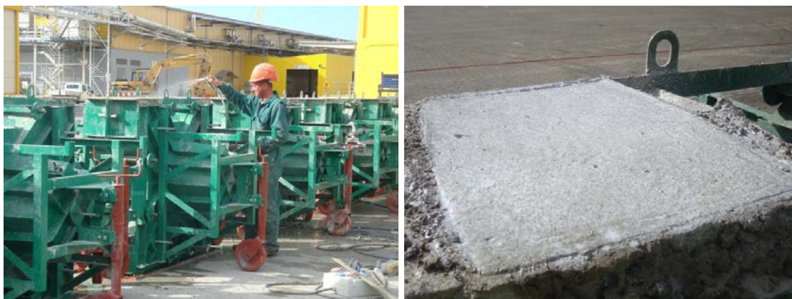
Figura 5-2: Kurimi i betonit të ekspozuar pas hedhjes
