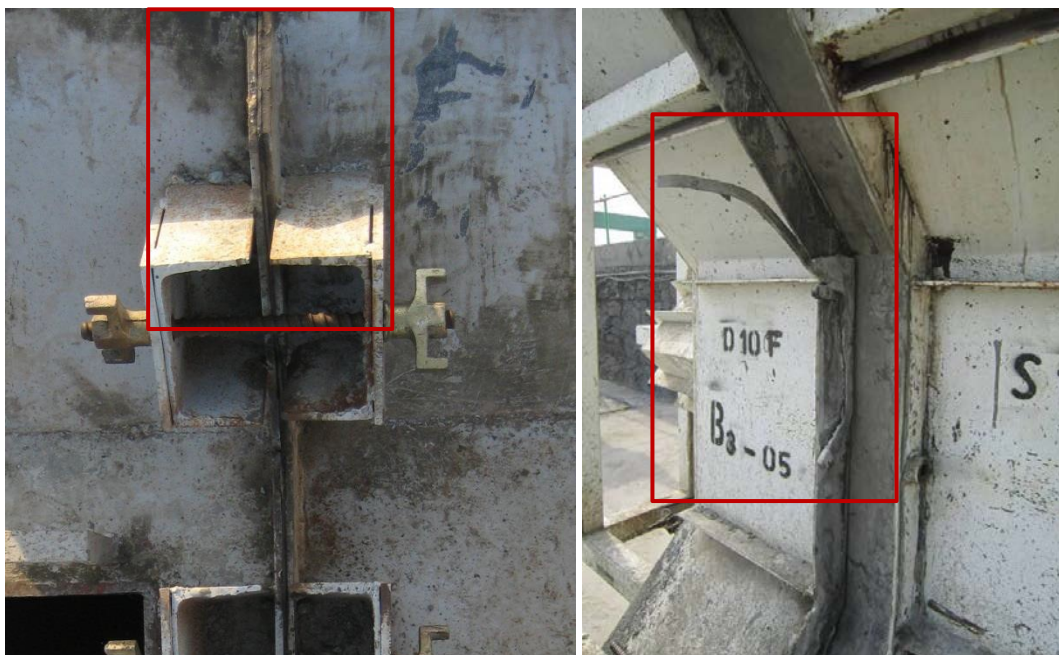
Figura 5-8: Parandaloni rrjedhjen duke vulosur kallëpin me paste (majtas), ose shiritat e gomës vetë-ngjitëse (djathtas)
