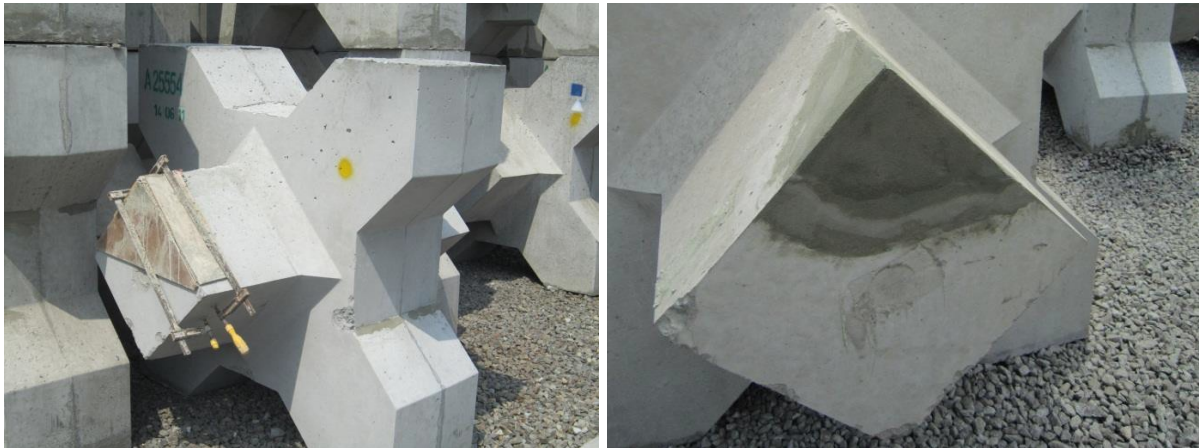
Figura 4-5: Riparimi i dëmtimeve mekanike të sipërfaqes
