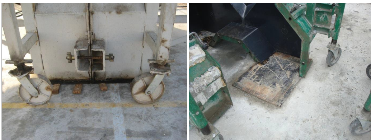
Figura 5-9: Parandaloni rrjedhjen në pjesën e poshtme të kallëpit duke përdorur një pllakë çeliku ose druri
