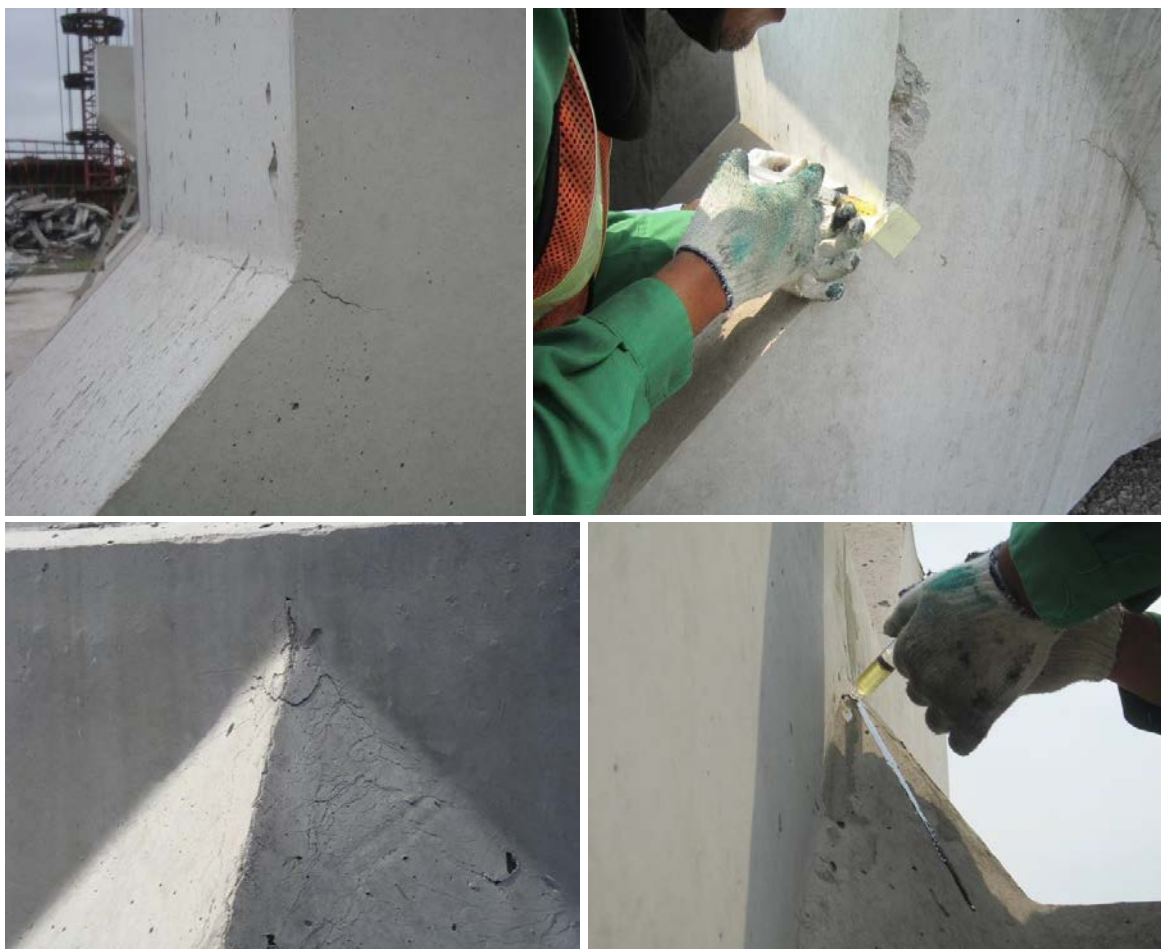
Figura 4-2: Riparimi i një çarjeje duke injektuar çarjen me epoksid
