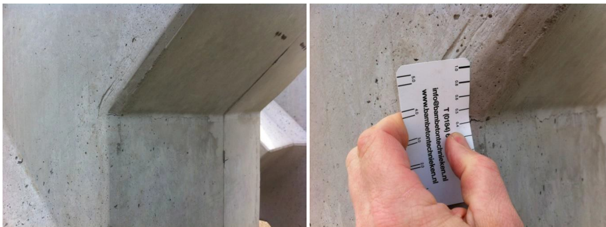
Figura 5-7: Çarje në këndin e sipërm të brendshëm
