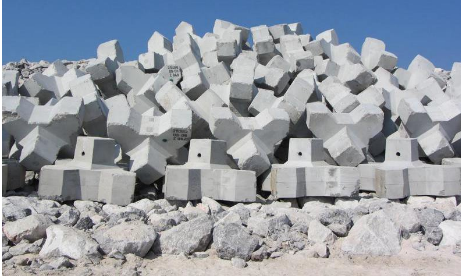
Figura 8-1: Vendosja e rregullt e njësive Xbase dhe njësive Xbloc në rreshtin vijues
