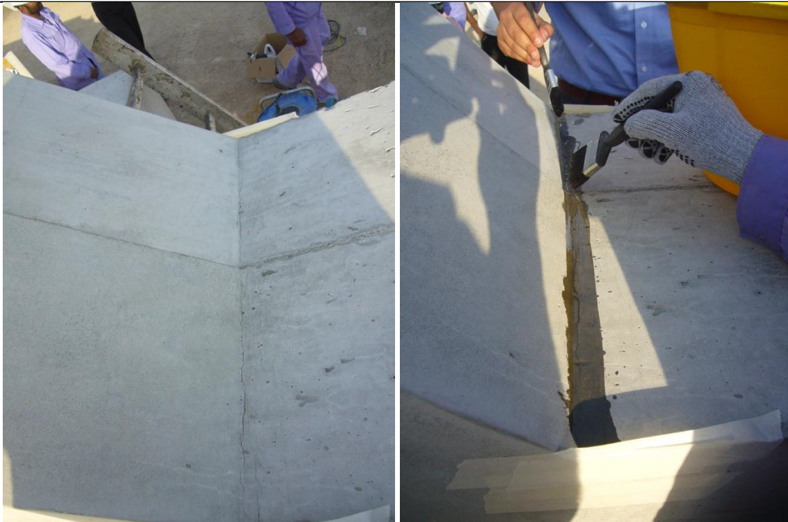
Figura 4-1: Riparimi i një çarjeje duke mbushur rezervuarin e krijuar me epoksid
