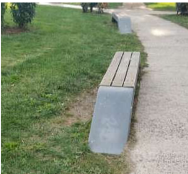
Foto 11 Stol betoni me ristela druri
