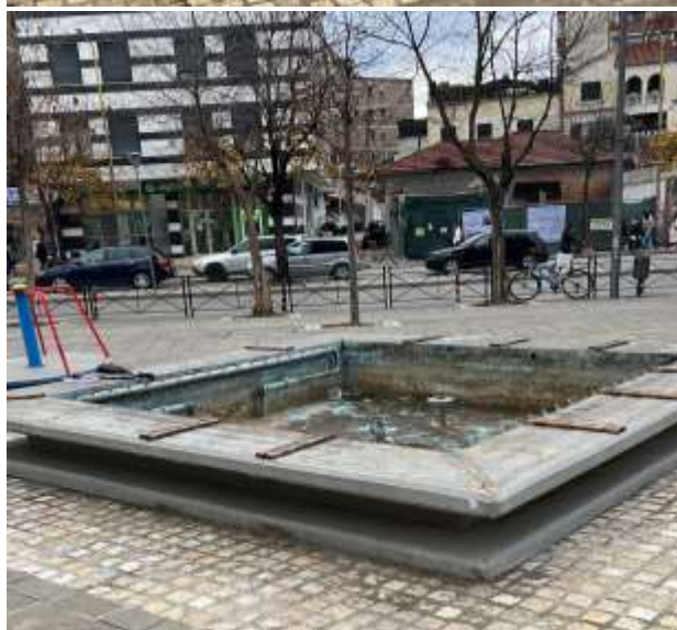
Foto 7 Stol drejtkëndor 396x468 cm me ristela druri me bazament betoni
