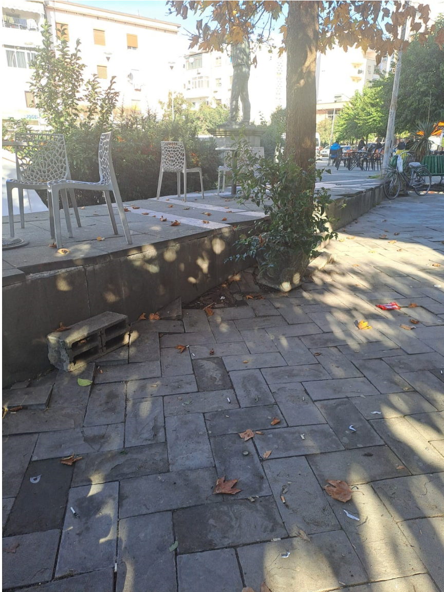
Foto. Segmenti I, Qendra e Qytetit Fushë Krujë
