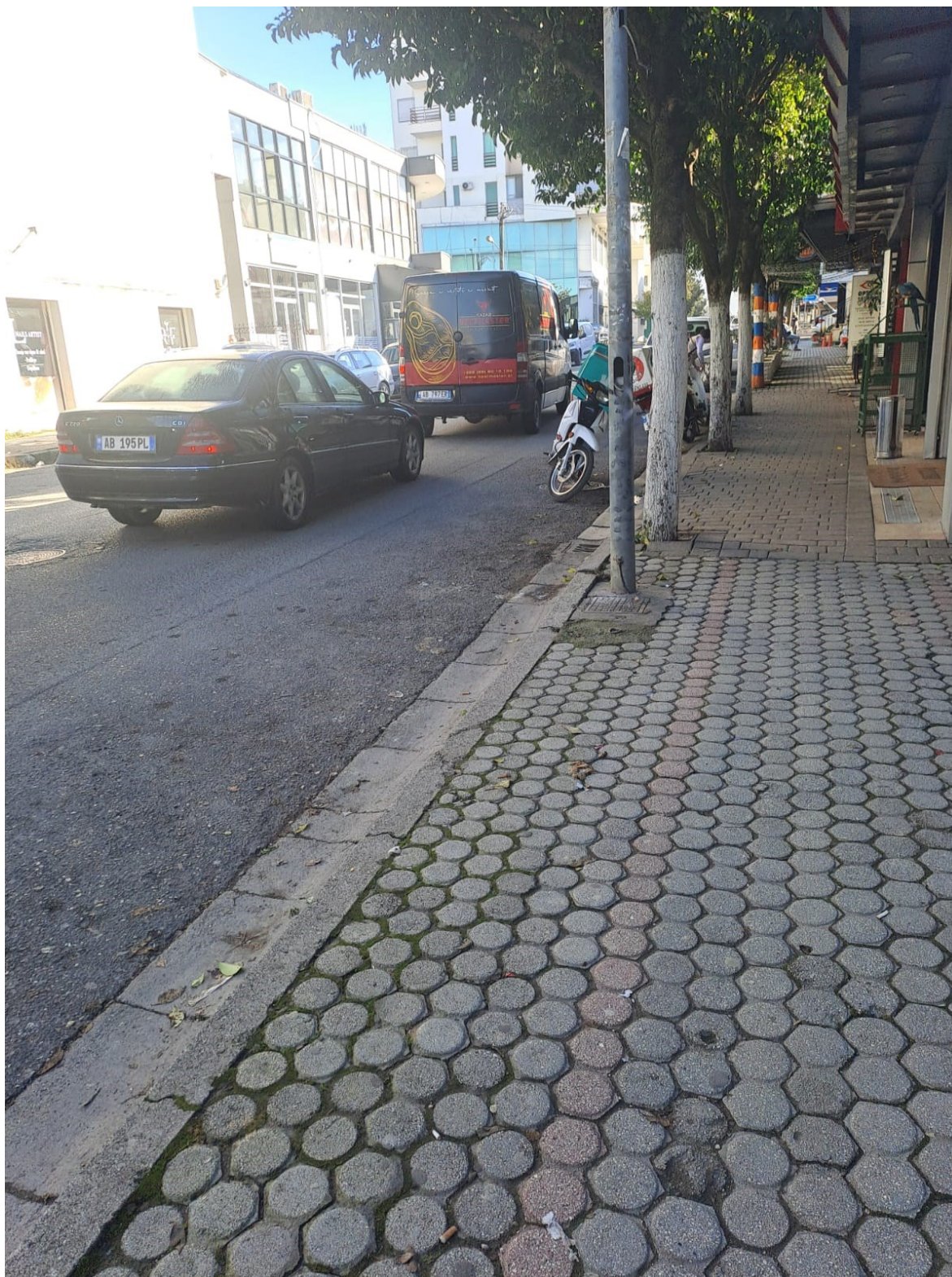
Foto. Segmenti 4, Shëtitorja e Bregut të Lumit
