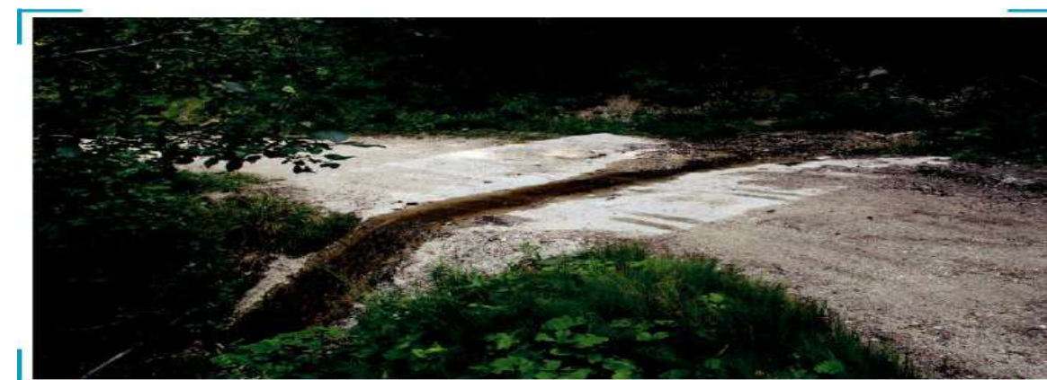
Fotografia 8: Shmangni krijimin e një shtrati me material anash rrugës për bartje (Fotografia: Juri Beguš)
