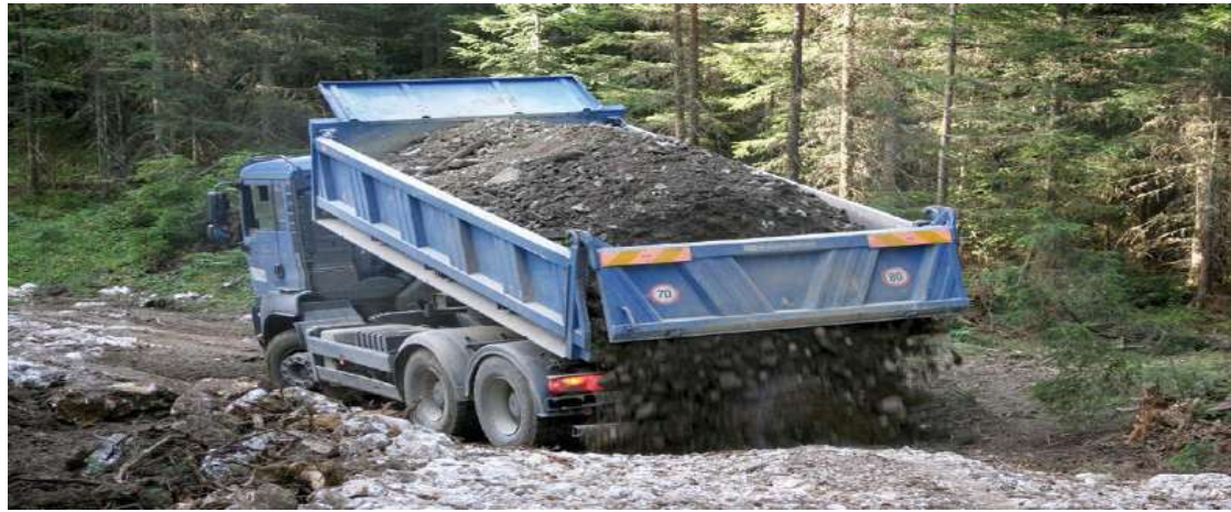
Fotografia 15: Kamionët përdoren për të transportuar dhe shpërndarë materialin
