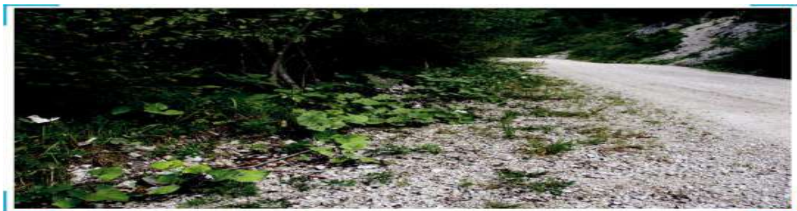
Fotografia 8: Shmangni krijimin e një shtrati me material anash rrugës për bartje (Fotografia: Juri Beguš)
