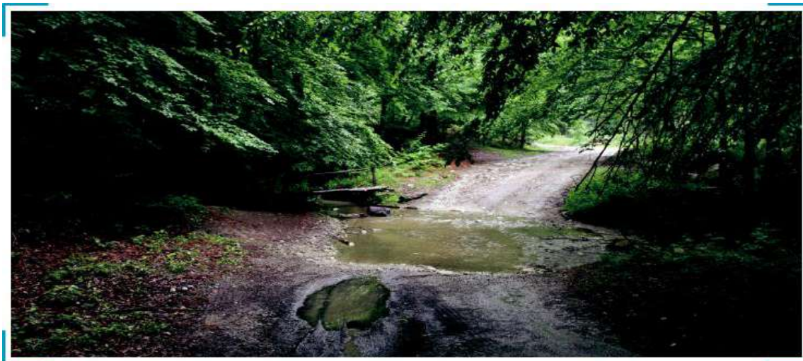
Fotografia 3: Një lug i bërë prej betoni ose guri duhet të parashihet në fazën e planifikimit për kalimine një përroi sikurse ky që është paraqitur më sipër (Fotografia: Juri Beguš)
