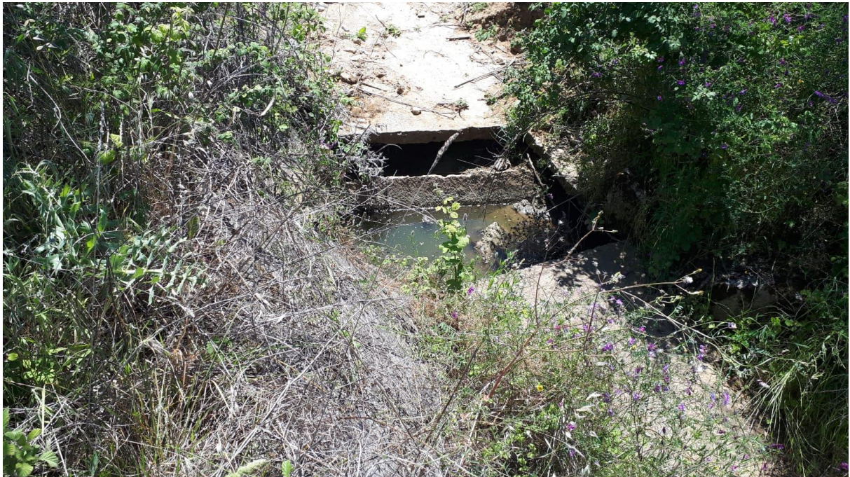
Fig.14 Pamje e thyerjes se betonit te shkarkuesit katastrofik
