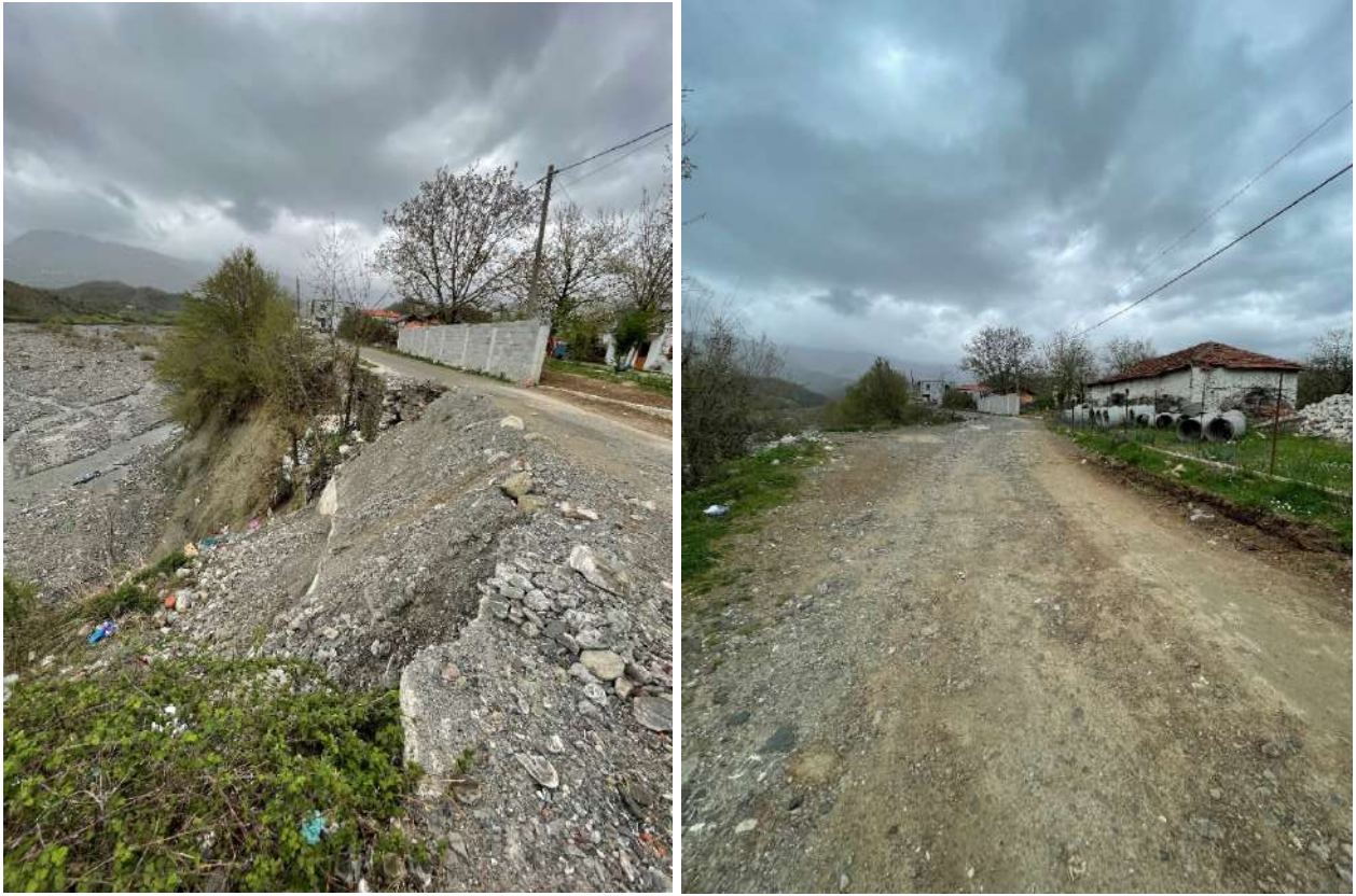
Figure 5 Rruga - gjendja ekzistuese –Shkarja
