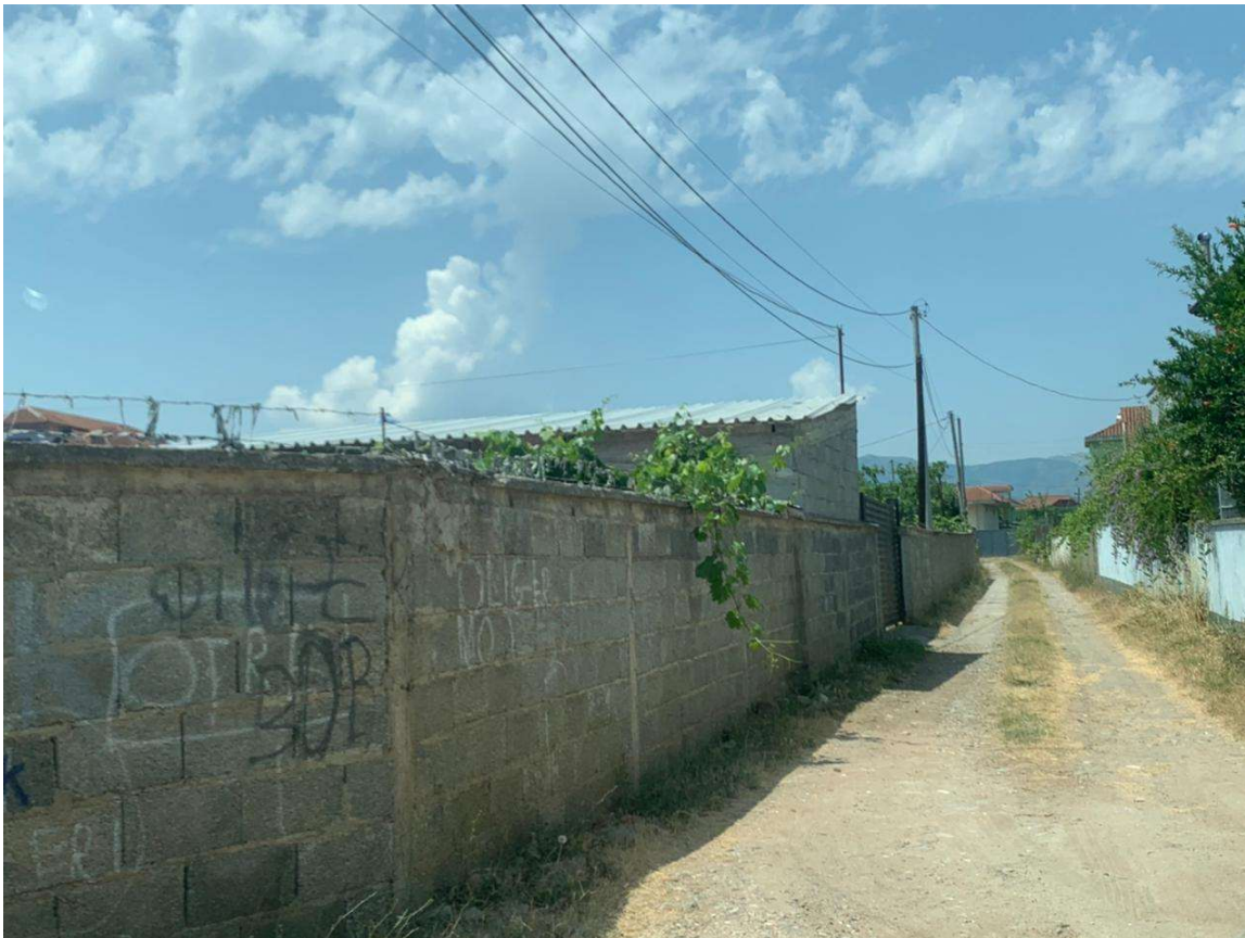
Fig.13 Rruge te paasfaltuara
