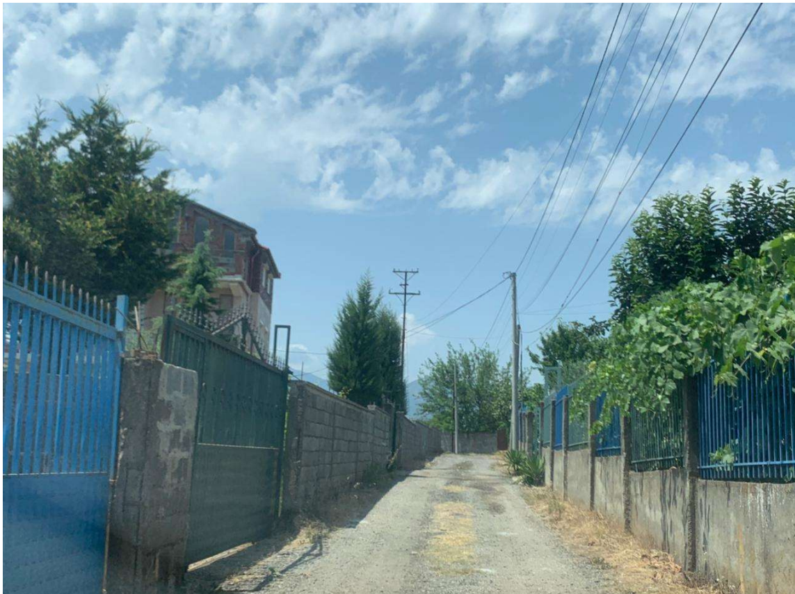
Fig.15 Rruge te paasfaltuara
