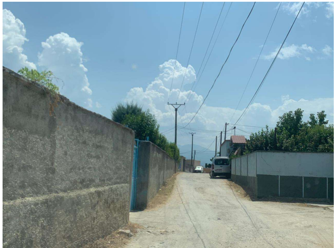
Fig.9 Rruge te paasfaltuara
