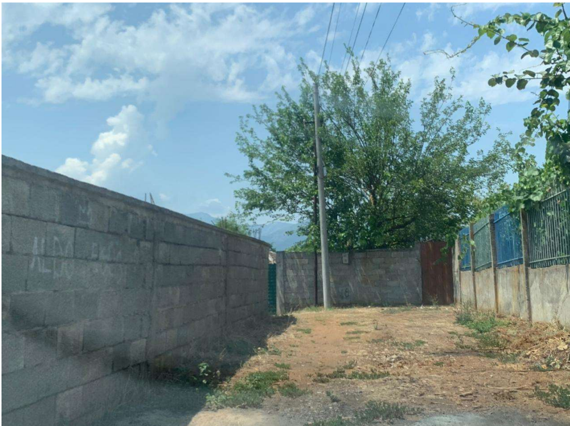
Fig.17 Rruge te paasfaltuara
