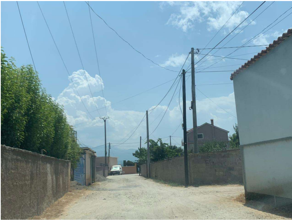
Fig.12 Rruge te paasfaltuara
