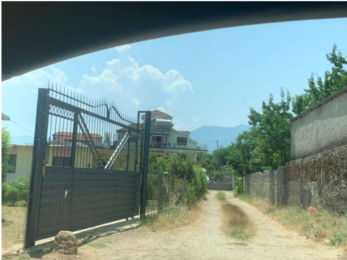
Fig.8 Rruge te paasfaltuara
