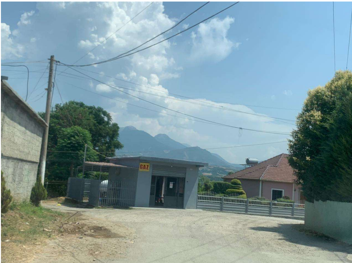
Fig.11 Rruge te paasfaltuara
