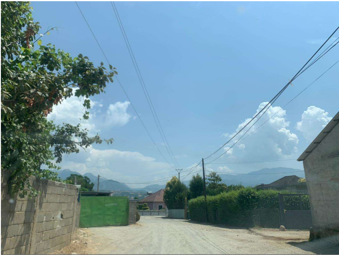
Fig.6 Rruge e paasfaltuar.
