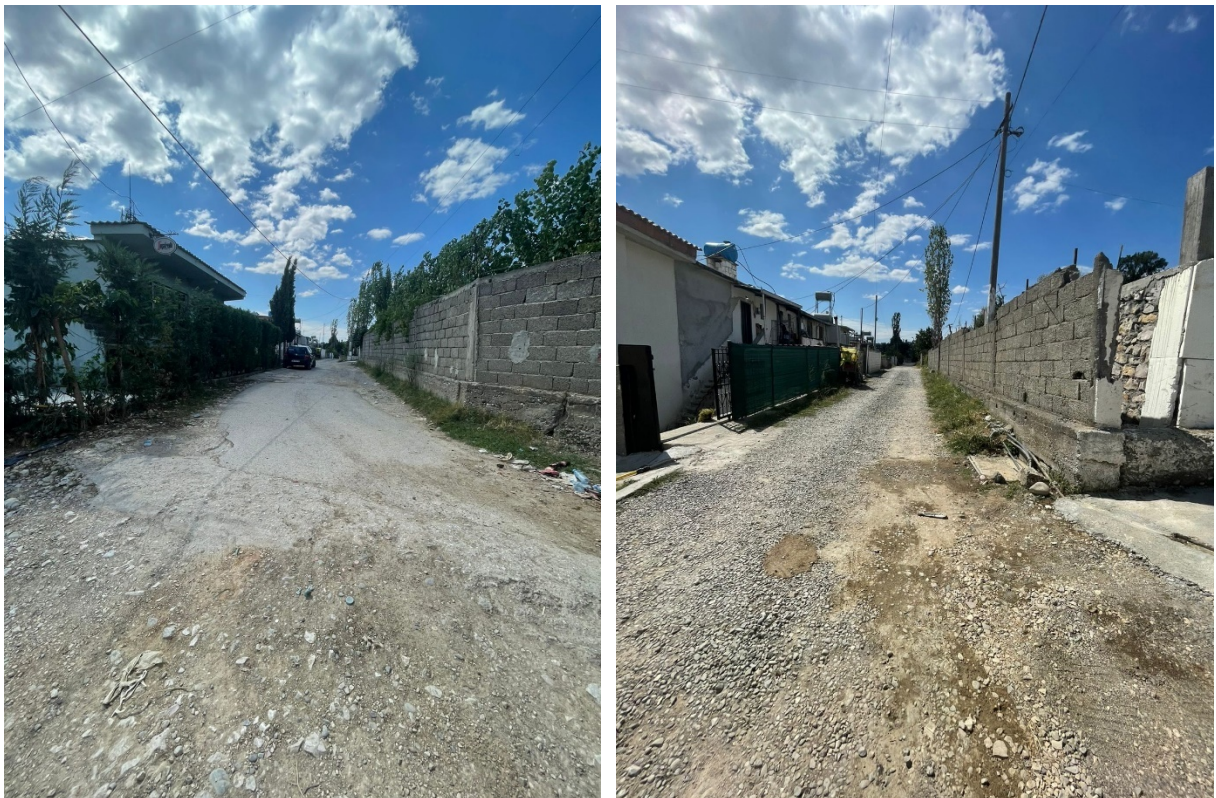
Figure 35 Pamje te gjendjes ekzistuese te demtuar
