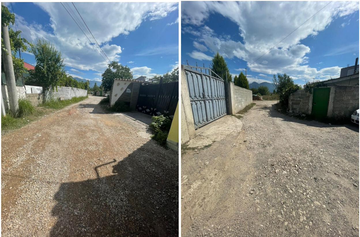
Figure 21 Rruge aksesi e degraduar
