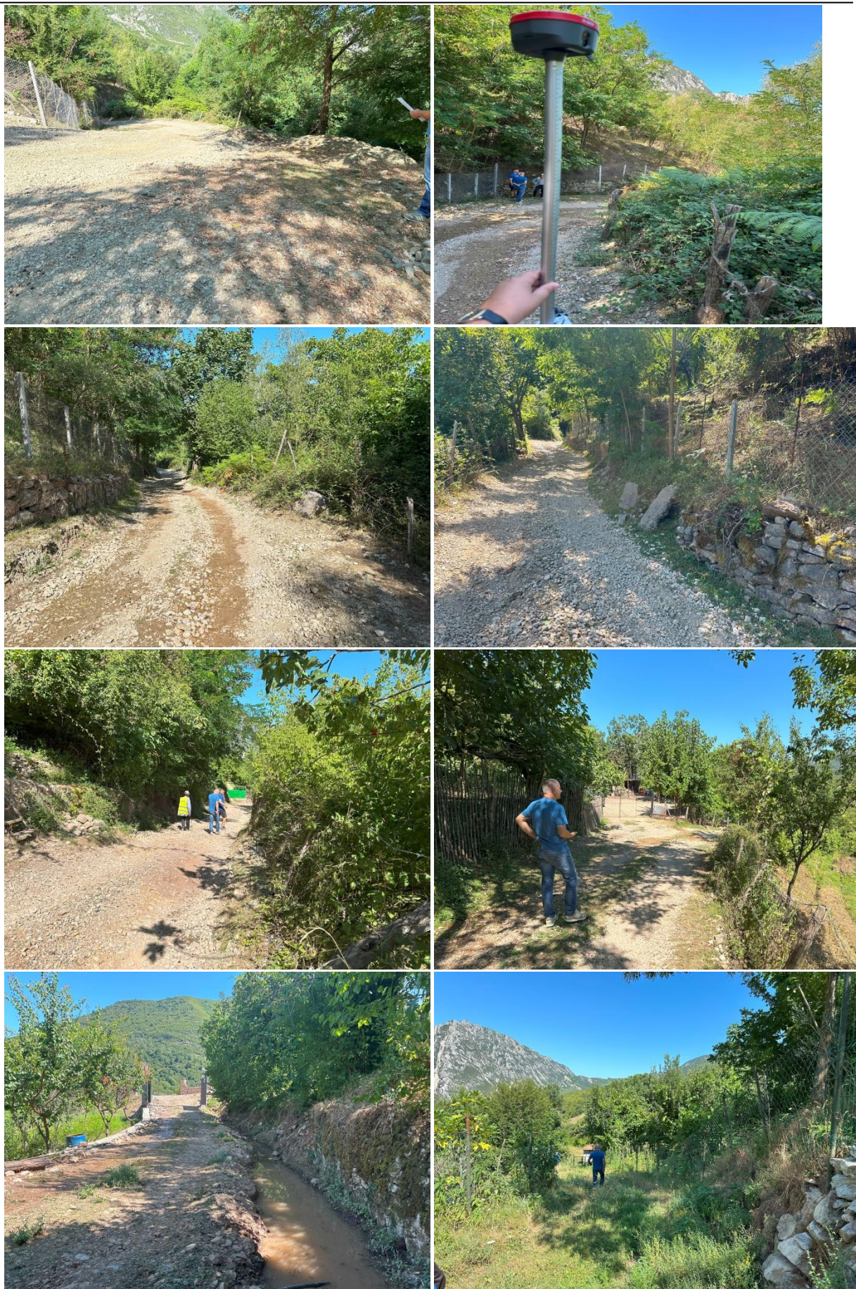
Figura 2, Foto të objektit në gjëndjen ekzistuese
