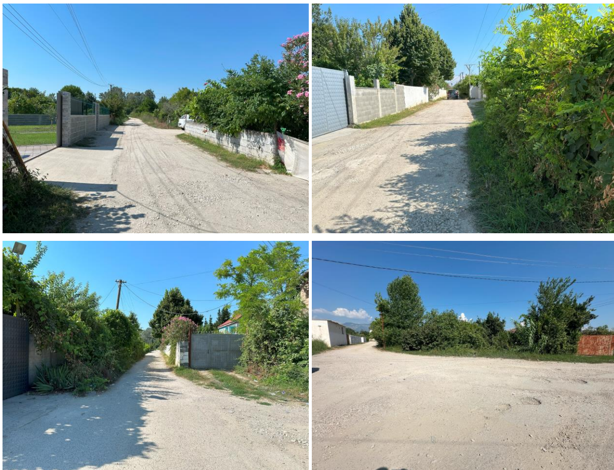
Figura 2, Foto të objektit në gjëndjen ekzistuese
