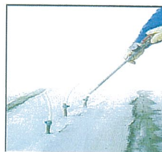
3- Injektimi i rezines epokside me pompe
