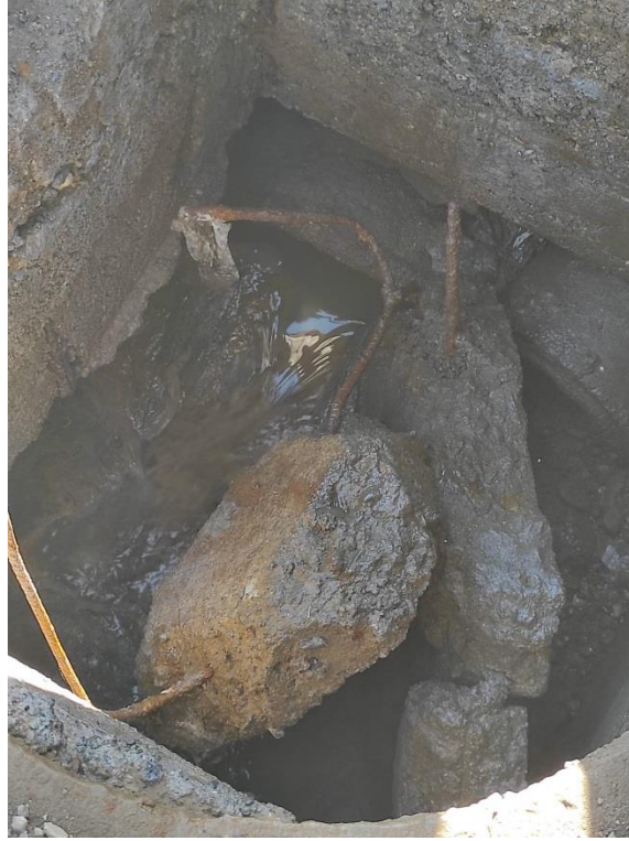
Pusefe e bllokuar me inerte betoni
