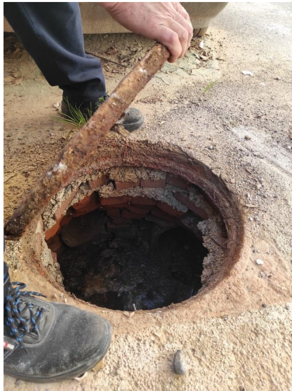
Pusefe e bllokuar me inerte betoni
