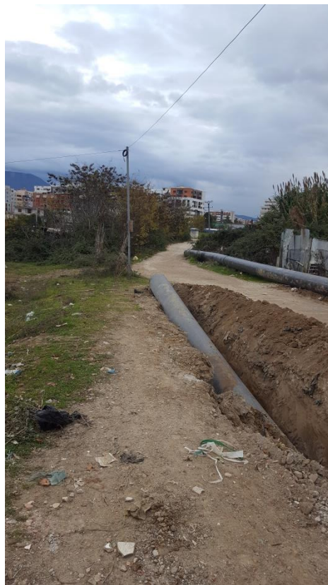
Pamje gjate punimeve per ndertimin e tubacionit Dj-630mm
