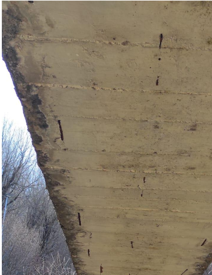
Pamje e struktures se ure kanalit, ku verehet armatura punuese
