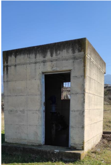
Puseta e ajruetit DN900mm prane Liqenit te Paskuqanit
