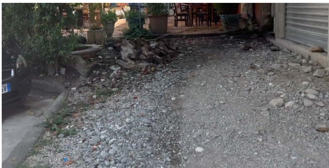
Fig 10. Foto te gjendjes ekzistuese te trotuarit
