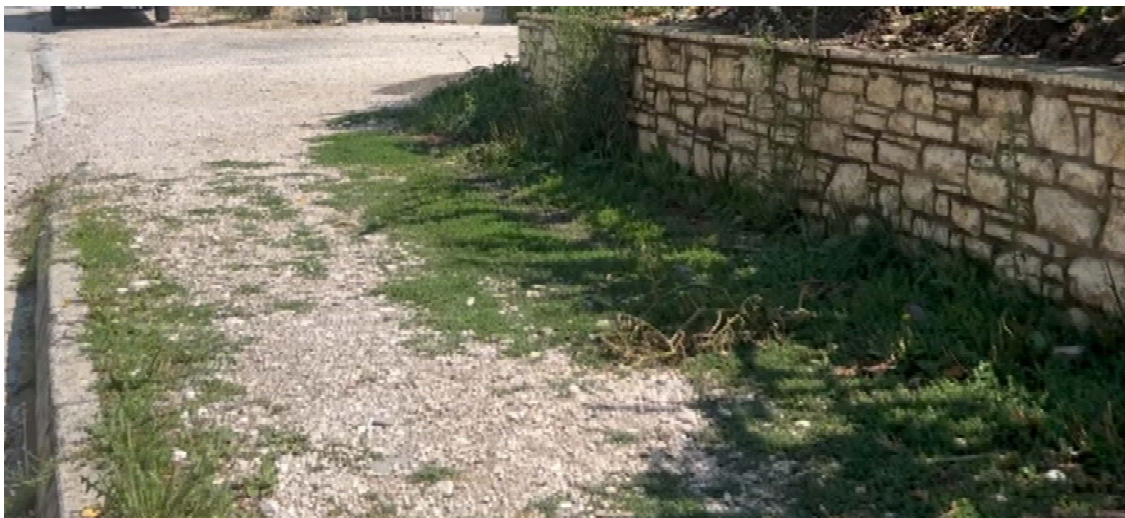
Fig 11. Foto te gjendjes ekzistuese te trotuarit
