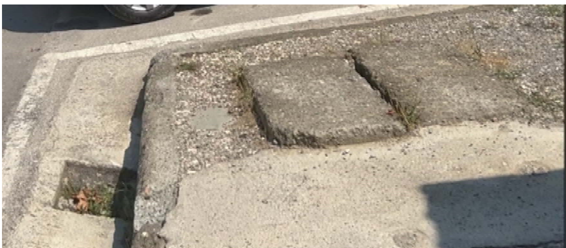
Fig 8. Foto te gjendjes ekzistuese te trotuarit
