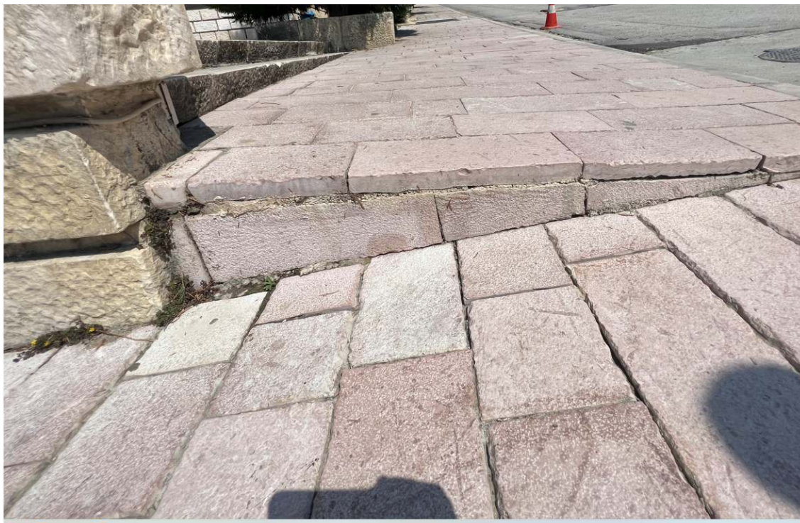
Fig 13. Foto te gjendjes ekzistuese te trotuarit
