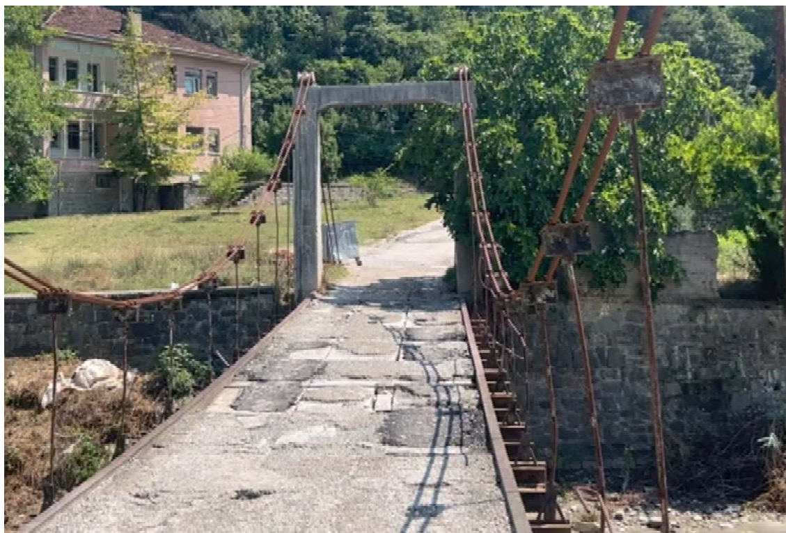
Fig 12. Foto te gjendjes ekzistuese te trotuarit
