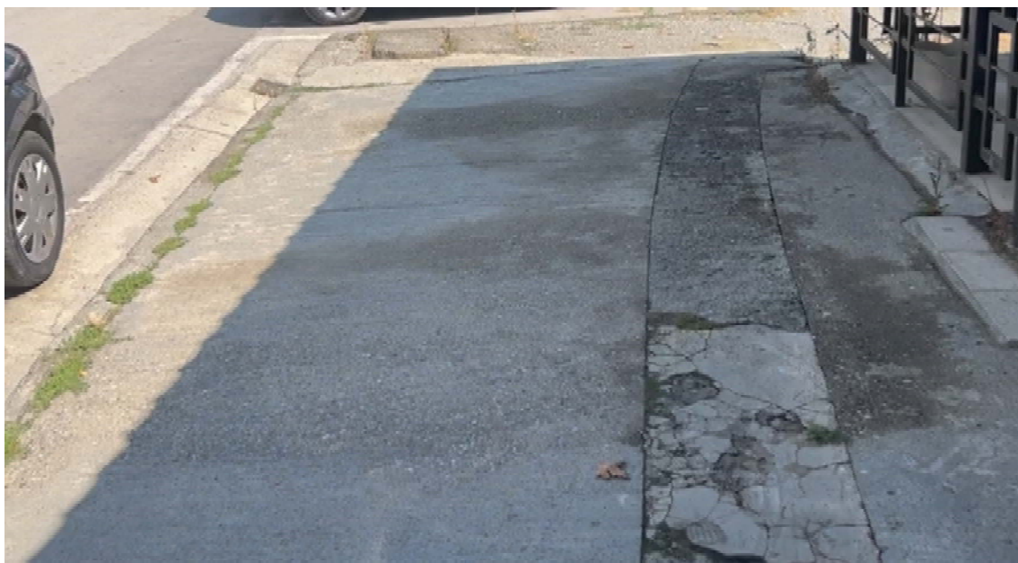
Fig 7. Foto te gjendjes ekzistuese te trotuarit
