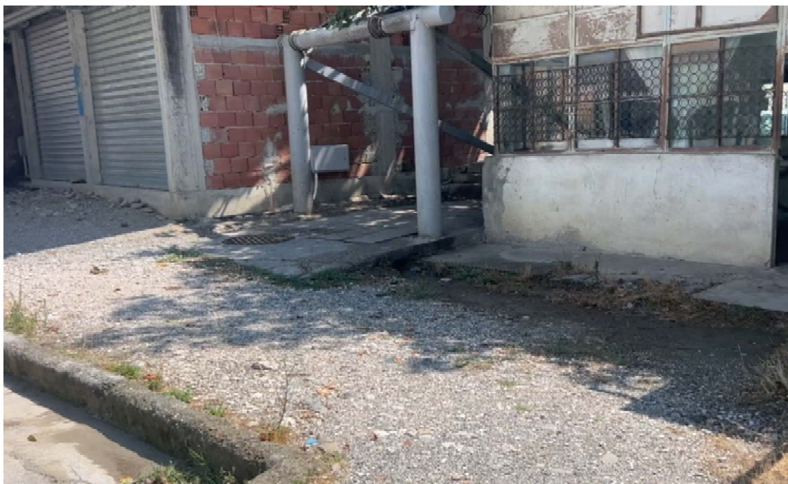
Fig 9. Foto te gjendjes ekzistuese te trotuarit
