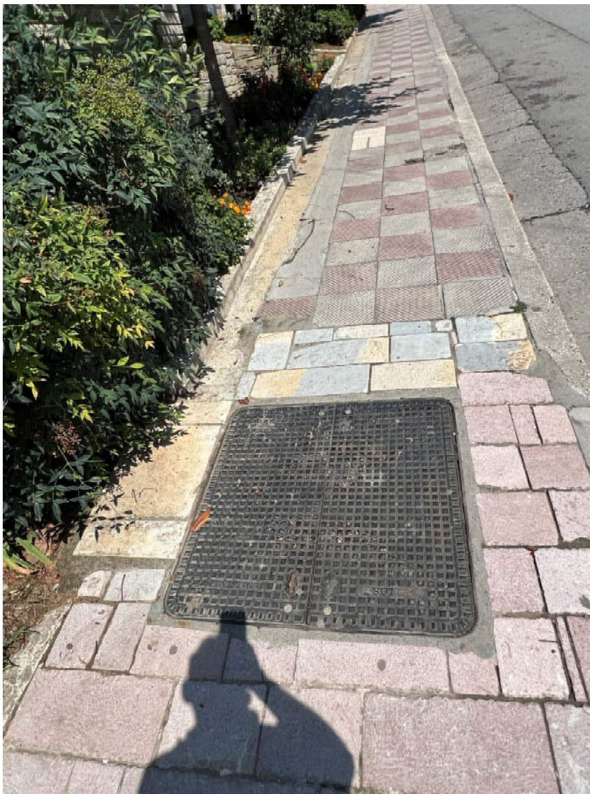
Fig 4. Foto te gjendjes ekzistuese te trotuarit
