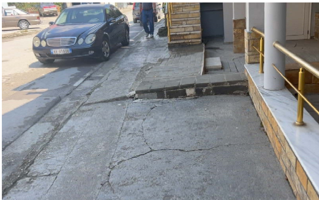
Fig 5. Foto te gjendjes ekzistuese te trotuarit
