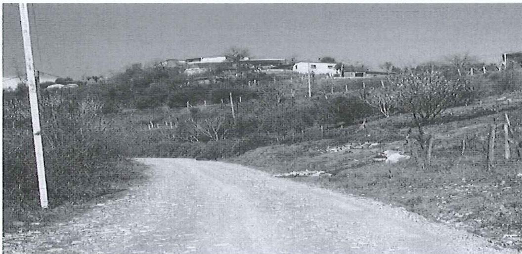
Fig.2: Foto të gjendjes ekzistuese të rrugës
