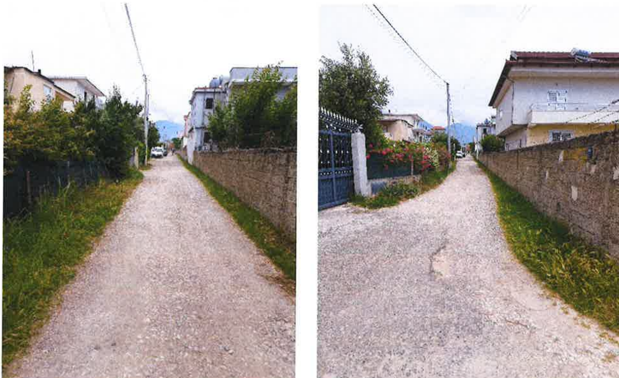
Foto te gjendjes ekzistuese Rruga Zapod
