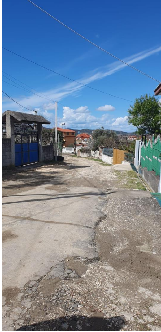
Foto te gjendjes ekzistuese
