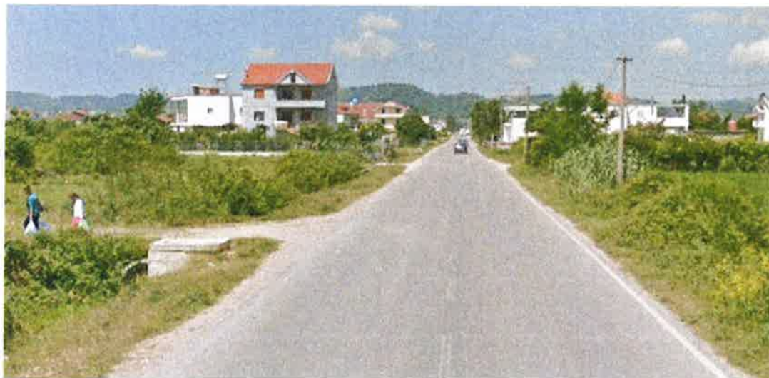
Foto te gjendjes ekzistuese
