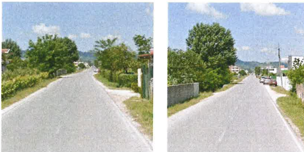
Foto te gjendjes ekzistuese
