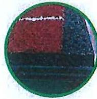
Shtresa e pare eshte shtrese betoni. Mbi beton shtrese binderi, shtrese elastike (9-11mm), shtrese spray mbi shtresen elastike (3-4mm)
