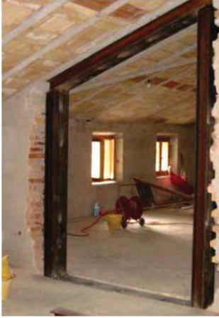
Fig. 2 – Perforcimi me element metalik per hapjet
