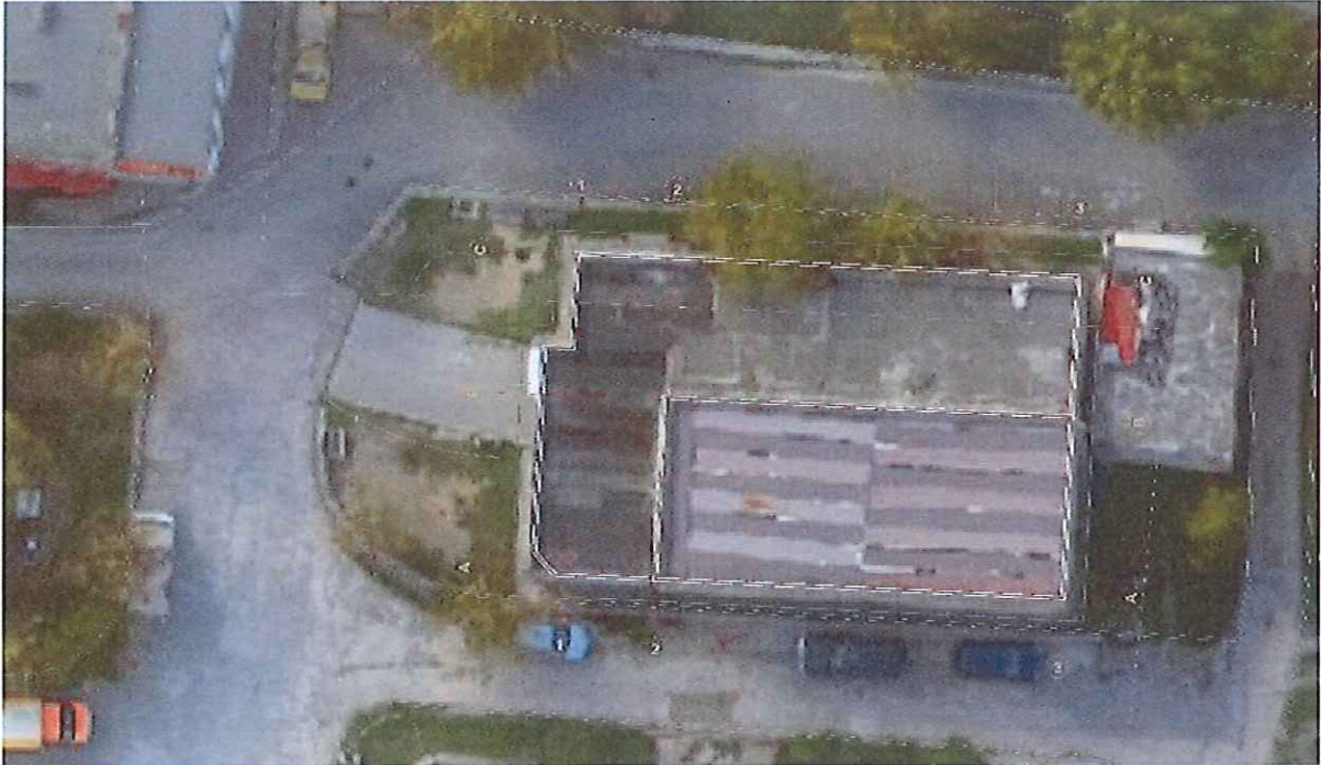
Foto te gjendjes ekzistuese
