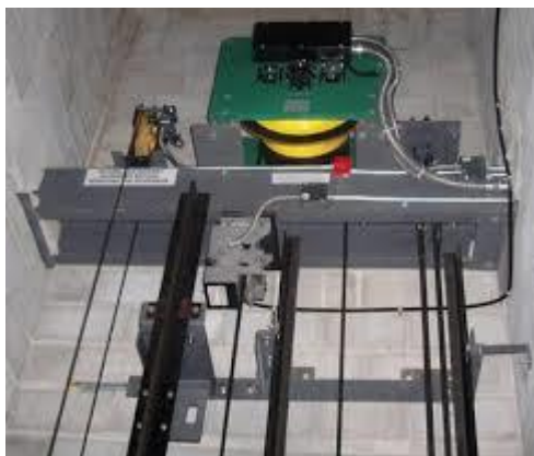
Fig. 3.3.1. Dhoma e makinerisë me mekanizmin e lëvizjes Te dhënat e motorrit të ashensorit
