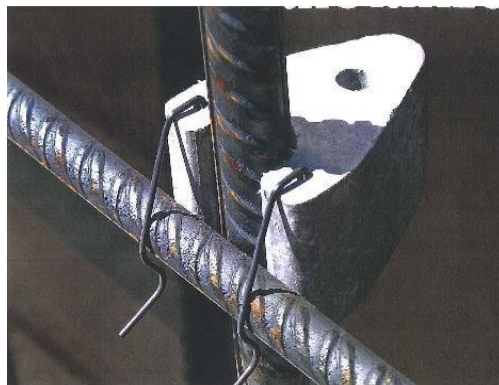
Figura 2 - Distancatorët për elementë vertikal
